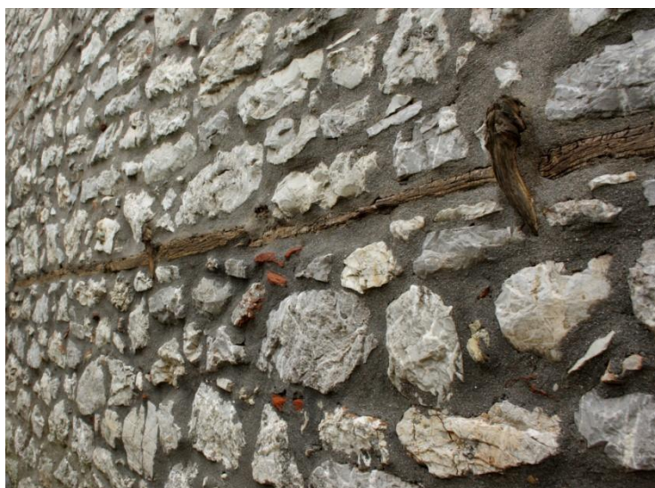
Εικόνα 19 λιθοδομή με ξυλοδεσιά
