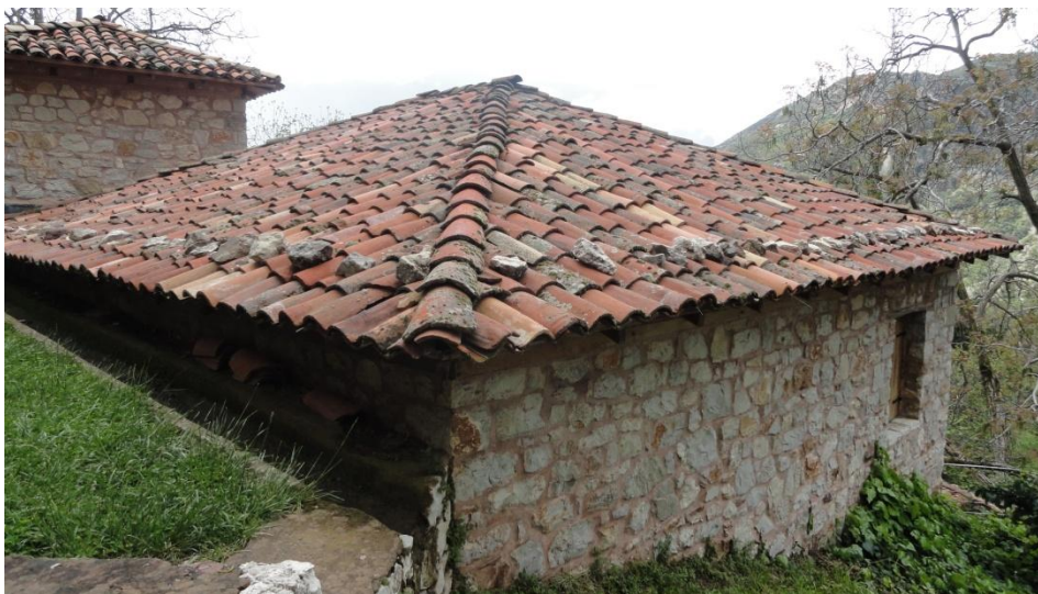
Εικόνα 23: Στέγη με βυζαντινά κεραμίδια
