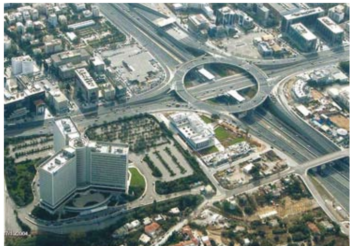
Φωτογραφία από το δοχτυλίδι του κόμβου της λεωφόρου Κηφισίας πηγή: http://el.wikipedia.org/wiki
