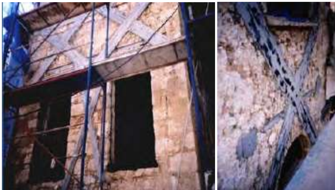
Εικόνα 45 Επικόλληση χιαστί συνθετικών ελασμάτων frp
