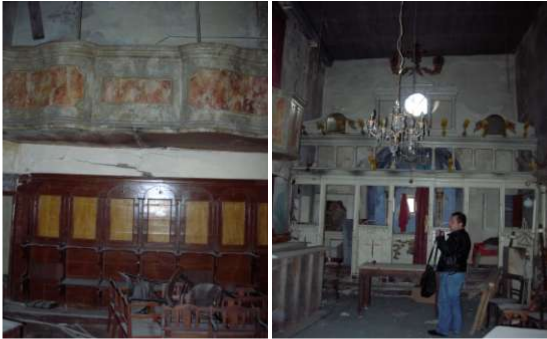
Εικόνα 24 Φωτογραφίες από το εσωτερικό του ναού. Η ουράνια που καλύπτει τις δοκούς της στέγης είναι εντελώς απλή από καρφωτές σανίδες, το τέμπλο ξυλόγλυπτο απλής μορφής, ομοίως ο γυναικωνίτης και ο άμβωνας, όλα βαμμένα.
