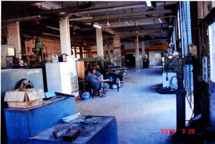
Χώρος Μηχανουργείου του ΑΗΣ Αλιβερίου
