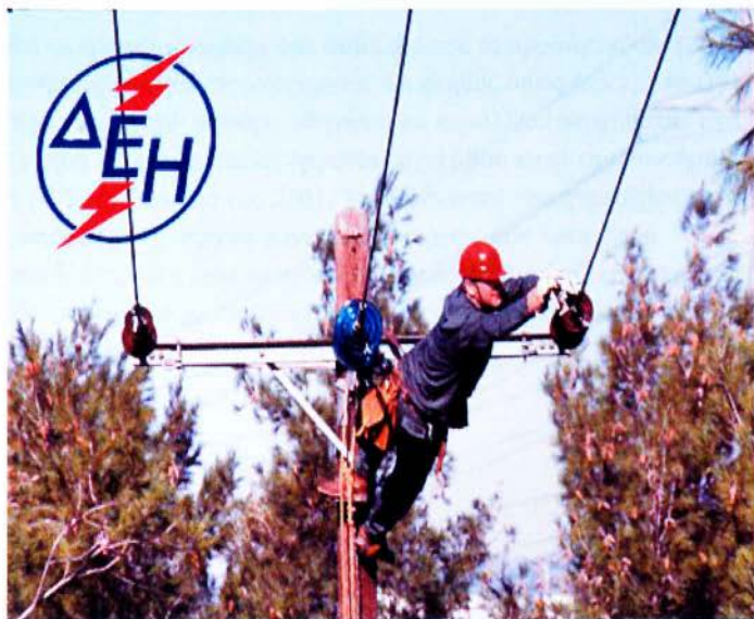
Συντήρηση αγωγών μεταφοράς ρεύματος
