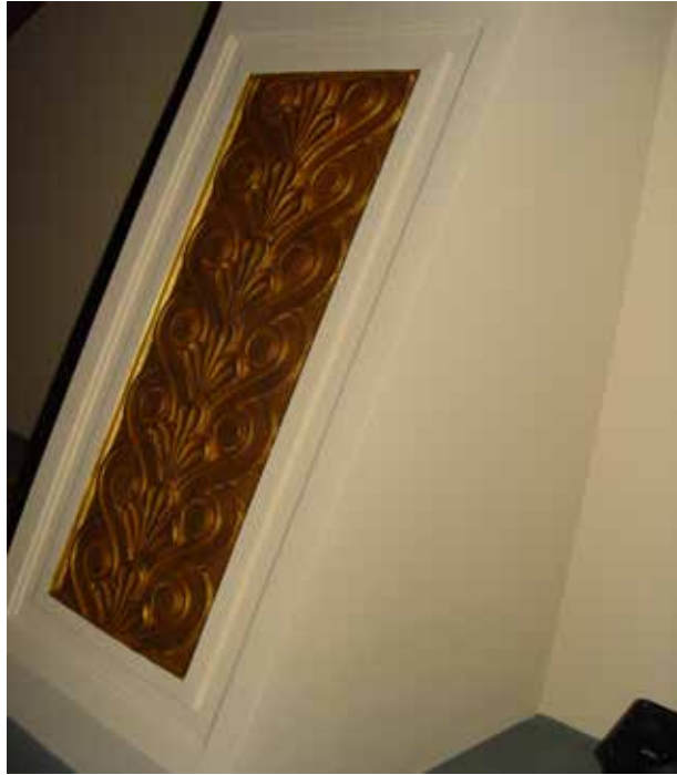
Εικόνα 38: Αποκατεστημένη λεπτομέρεια επίχρυσου δοκαριού
