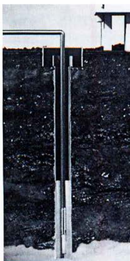
Εικόνα 2-16 Εγκατάσταση Υποβρύχιας Αντλίας
