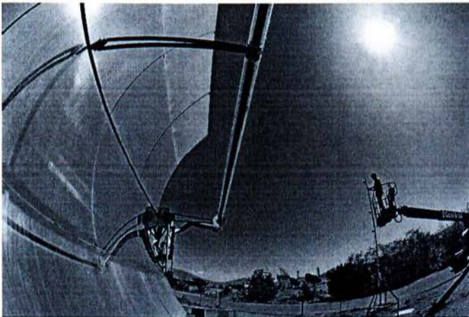
Εικόνα 3.2 Συγκεντρωτικός συλλέκτης με επιμήκη παραβολικά κάτοπτρα [16]
