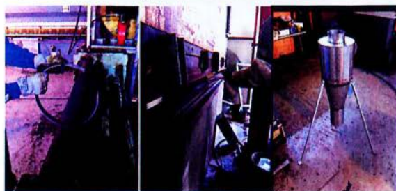
Εικ. 34 Κατασκευή πλαισίου στήριξης κυκλώνα.
