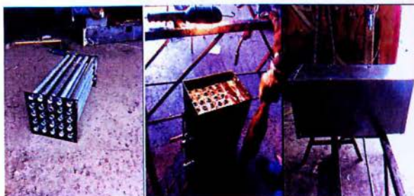
Εικ. 32 Κατασκευή εναλλάκτη θερμότητας.
