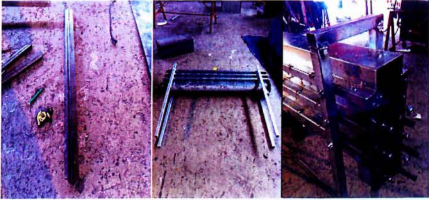
Εικ. 29 Κατασκευή πλαισίου στήριξης και κορμού διαδρομών.
