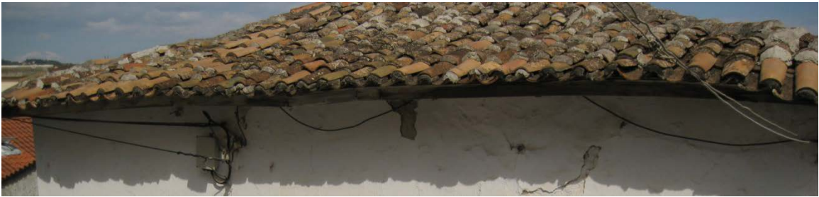
Εικόνα 18 Λεπτομέρεια από την υπάρχουσα στέγαση.
