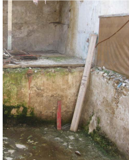
Εικόνα 22 Λήψη πρόσθετων μέτρων ασφαλείας, εξαιτίας των οριζόντιων ωθήσεων στην κατακόρυφη παρειά του υπογείου.
