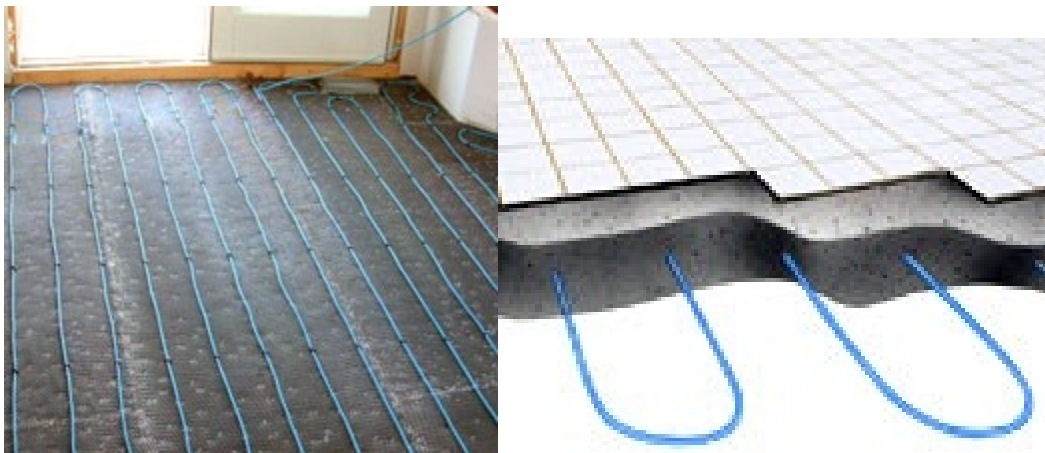
Εικόνα 34 Σύστημα ενδοδαπέδιας θέρμανσης
