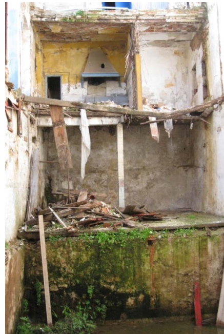
Εικόνα 23 Για υποστύλωση σε πολλούς ορόφους όπως ενδείκνυται στην περίπτωση του κτιρίου μελέτης.
