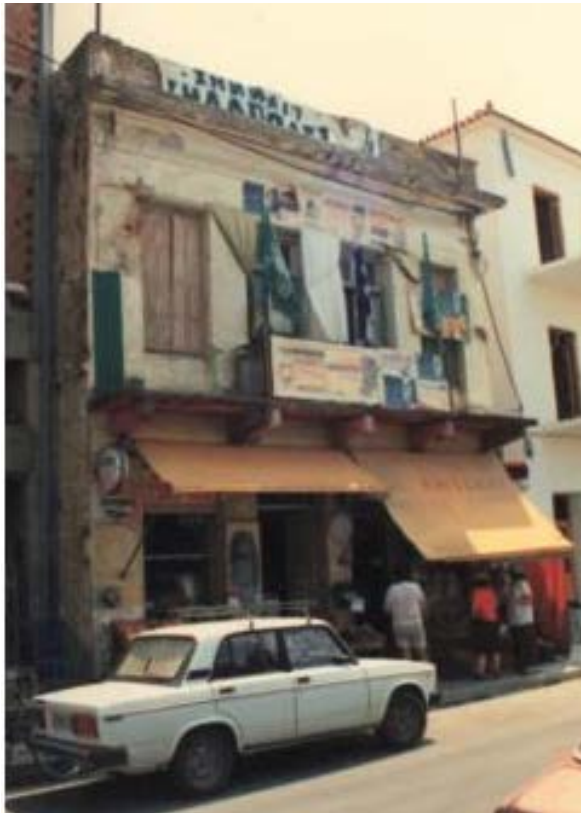
Εικόνα 2 Φωτογραφία του κτίσματος τη δεκαετία του 1980.
