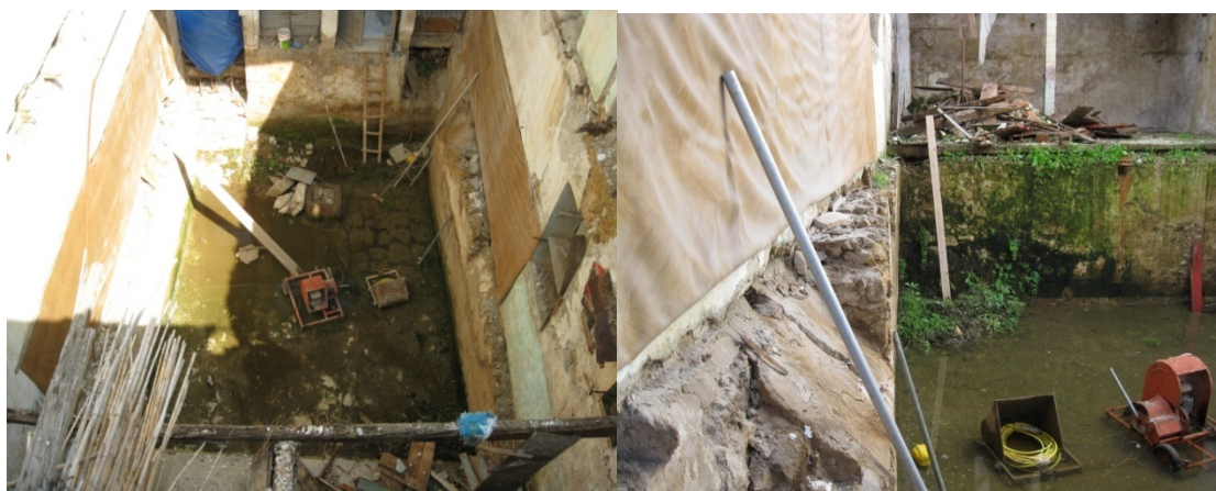
Εικόνα 19 Στο χώρο του υπογείου βρίσκονται νερά και μπάζα, τα οποία θα πρέπει να καθαριστούν.
