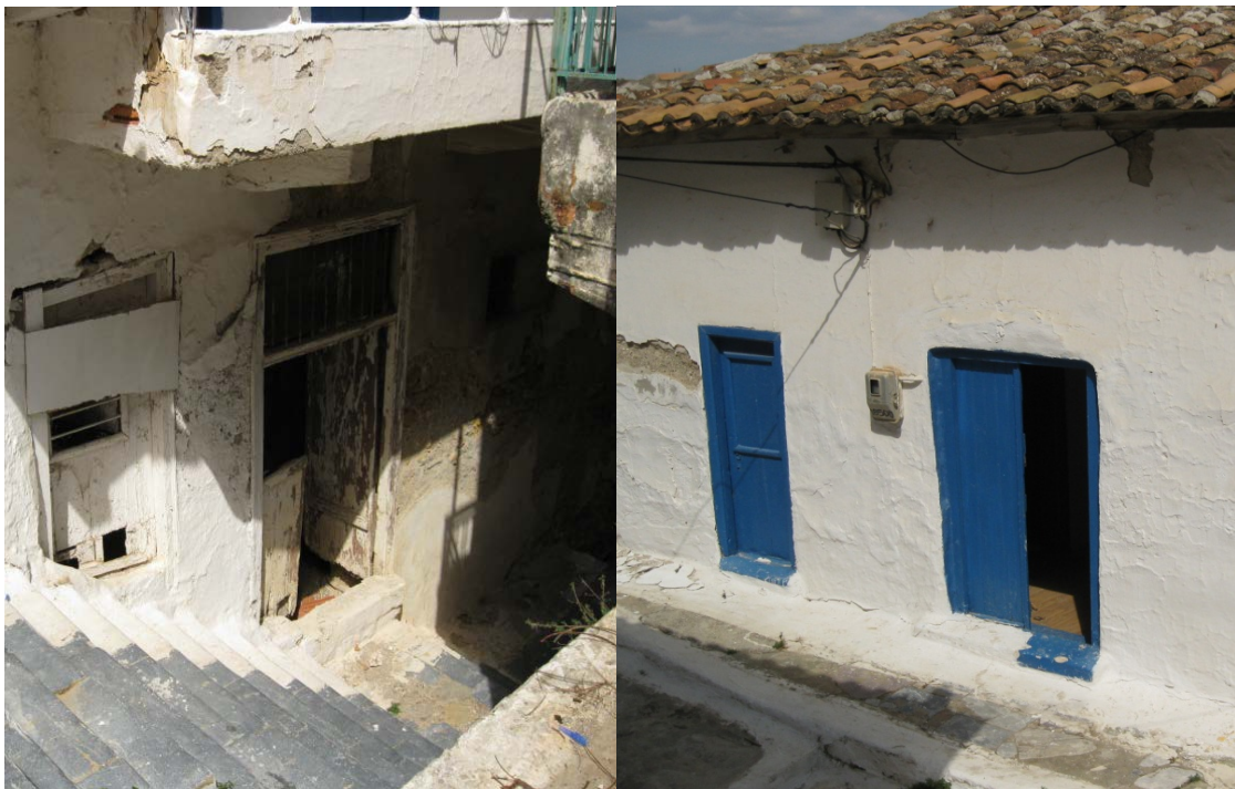
Εικόνα 17 Στο σύνολο τους τα κουφώματα του κτιρίου δεν προσφέρουν προστασία στο κτίριο.
