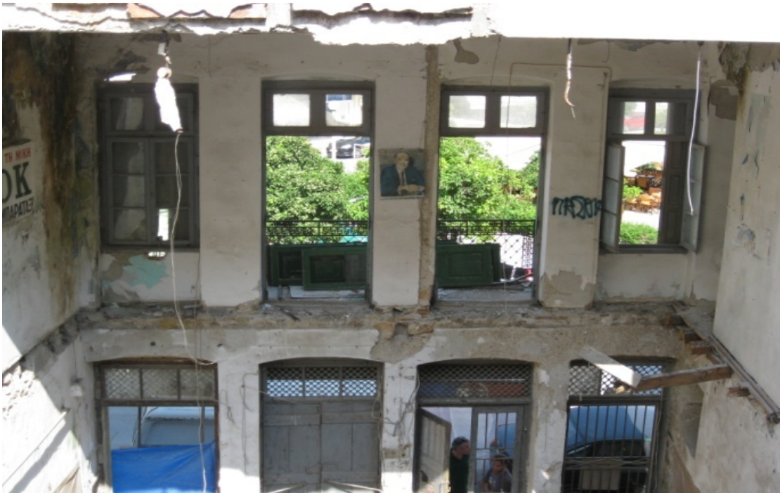
Εικόνα 10 Το μπροστινό τμήμα του κτιρίου, δεν φέρει πλέον πατώματα.
