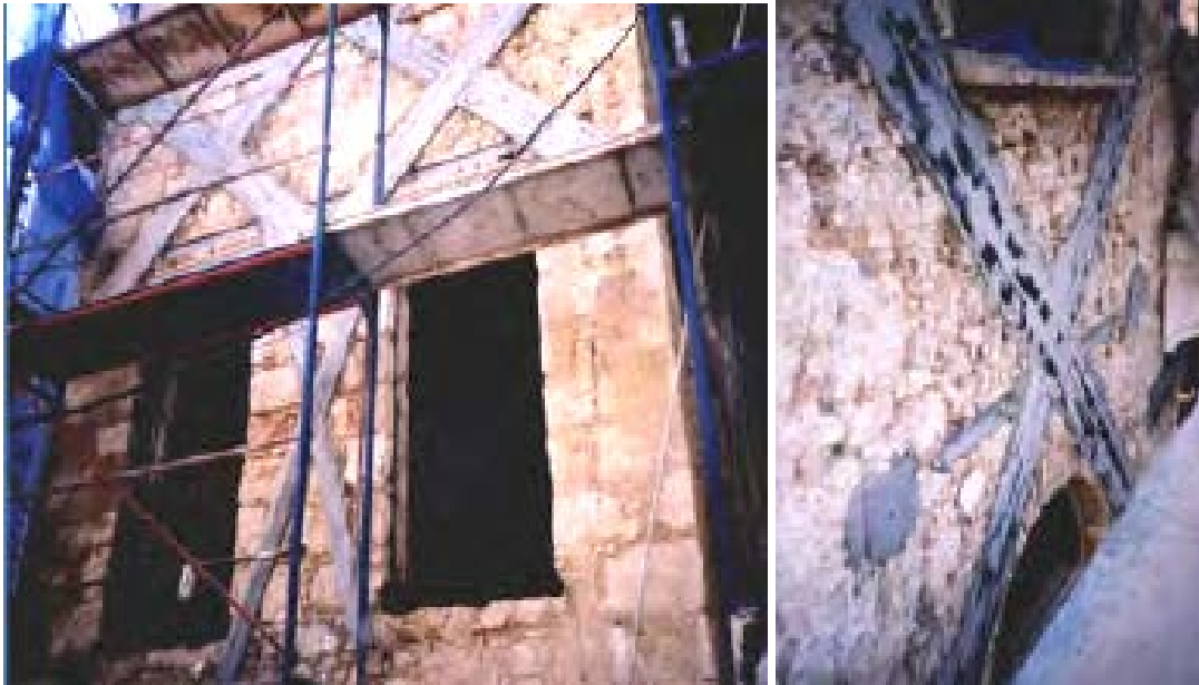
Εικόνα 27 Επικόλληση χιαστί συνθετικών ελασμάτων frp
