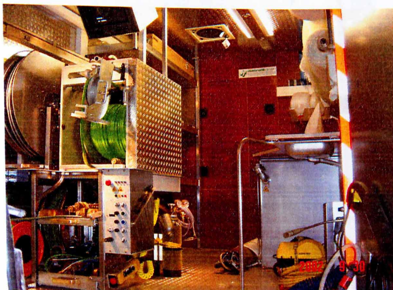
Εικόνα 5.9: Χώρος προετοιμασίας επισκευής(ΕΥΔΑΠ 2012)
