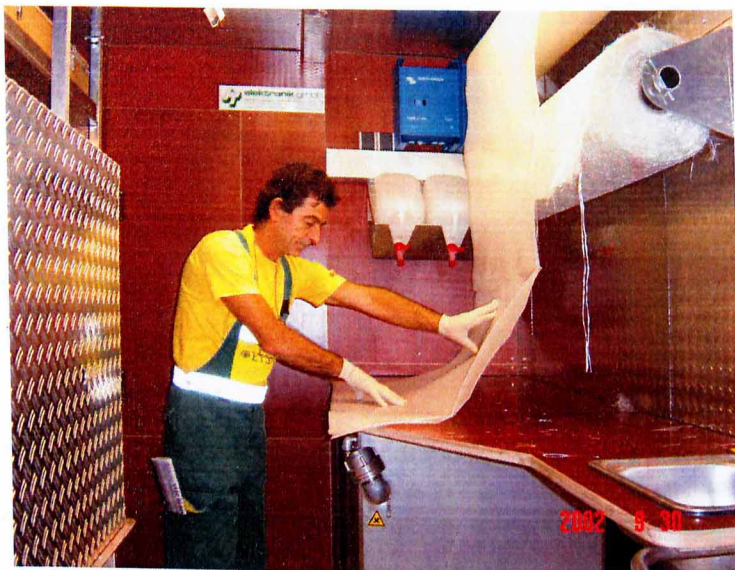
Εικόνα 5.10: Προετοιμασία υλικών εσωτερικής επικάλυψης(ΕΥΔΑΠ 2012)
