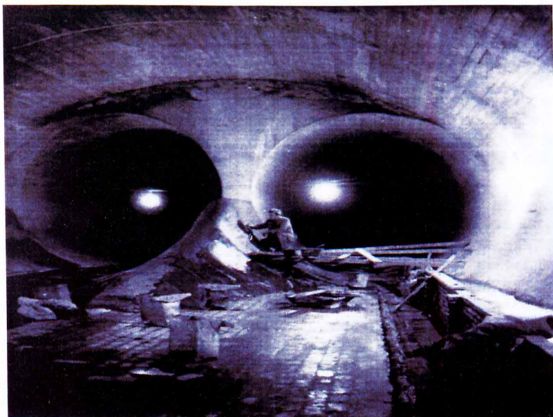
Εικόνα 1.4 : Κατασκευή διδύμου Παριλίσιου αγωγού (ΕΥΔΑΠ 2009)
