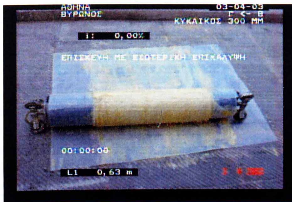
Εικόνα 5.12: Επίσκεψη εσωτερικής επικάλυψης προ εφαρμογής(ΕΥΔΑΠ 2012)
