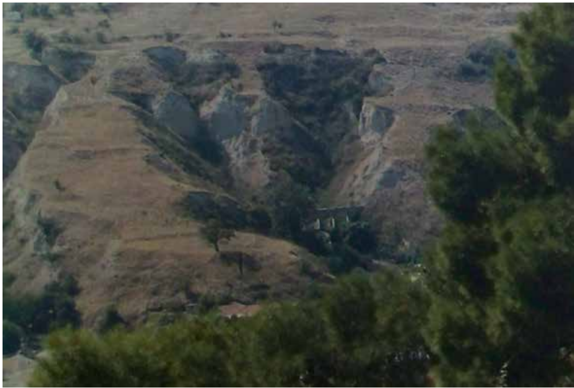
Σέρρες υδραγωγείο στη θέση Μουσάλα
