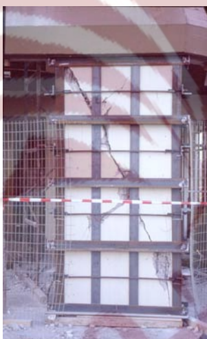
σχημα επεμβαση με μεταλλικο κλωβο για προσωρινη αναληψη κατακορυφων φορτιων
