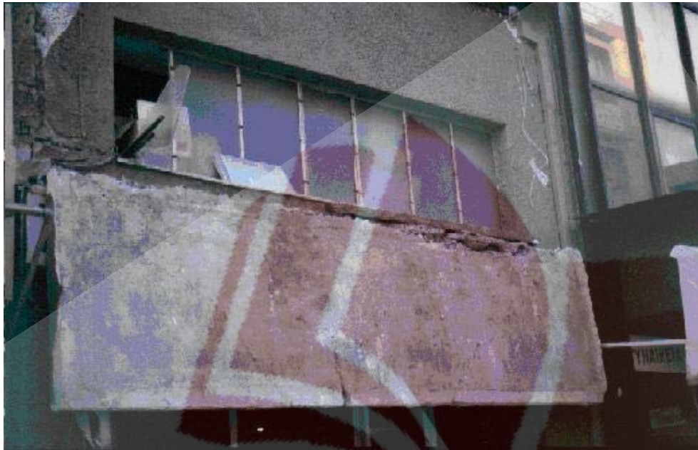
Σχήμα 9. Τσιμεντένια μαρκίζα στην οποία προϋπήρχαν βλάβες και η οποία κατέρρευσε με το σεισμό του 1986 στην Καλαμάτα.
