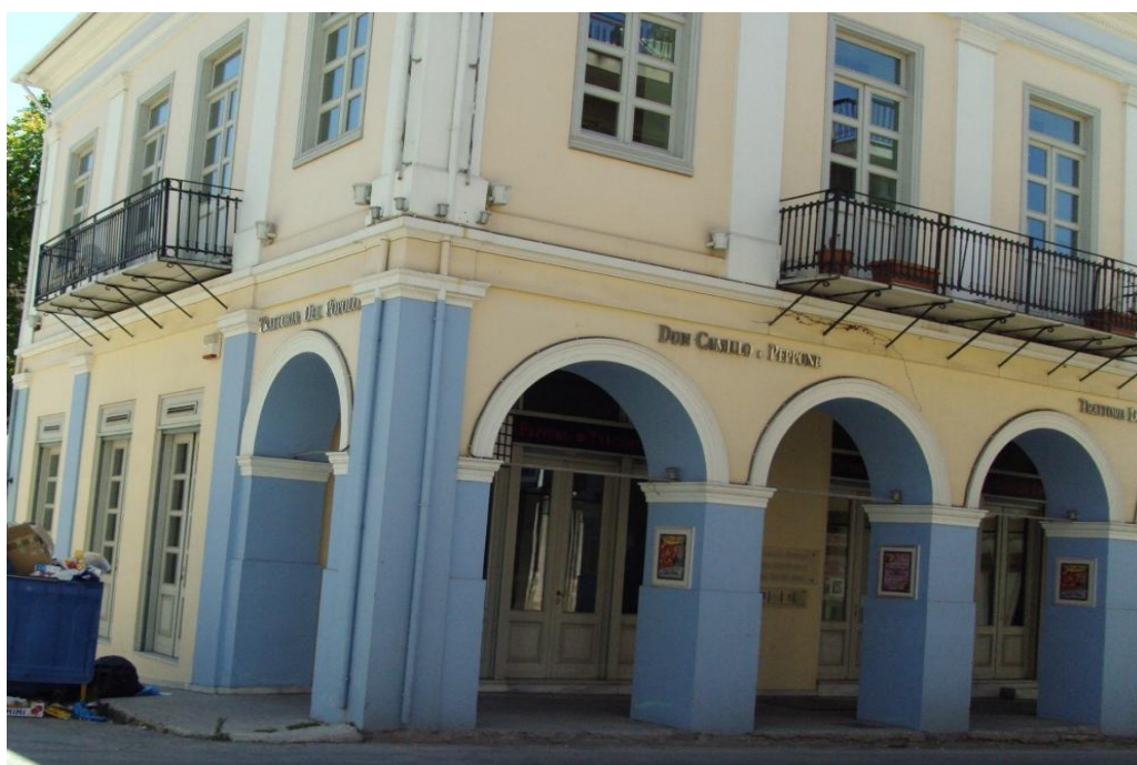
Σχ. 6.4 άποψη των ελκυστήρων κατά μήκος των τόξων.
