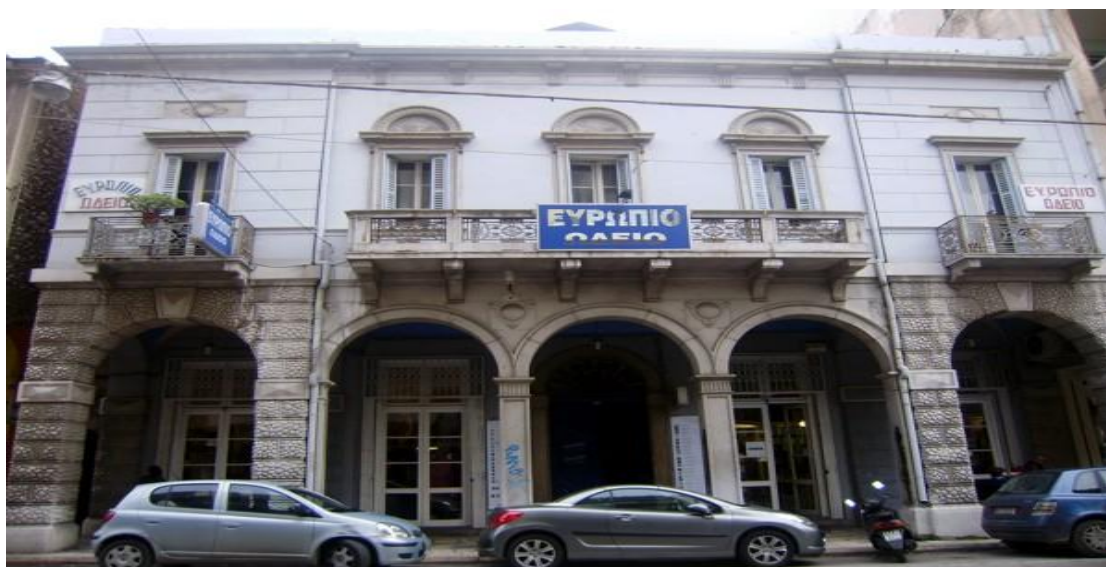
Σχ 3.14 όψη όψιμου κτιρίου (Πάτρα οδός Κανακάρη)
