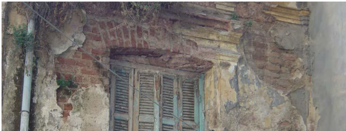
Σχ 6.11 Φέρουσα λιθοδομη και ανακουφιστικό τόξο ανοίγματος. 16
