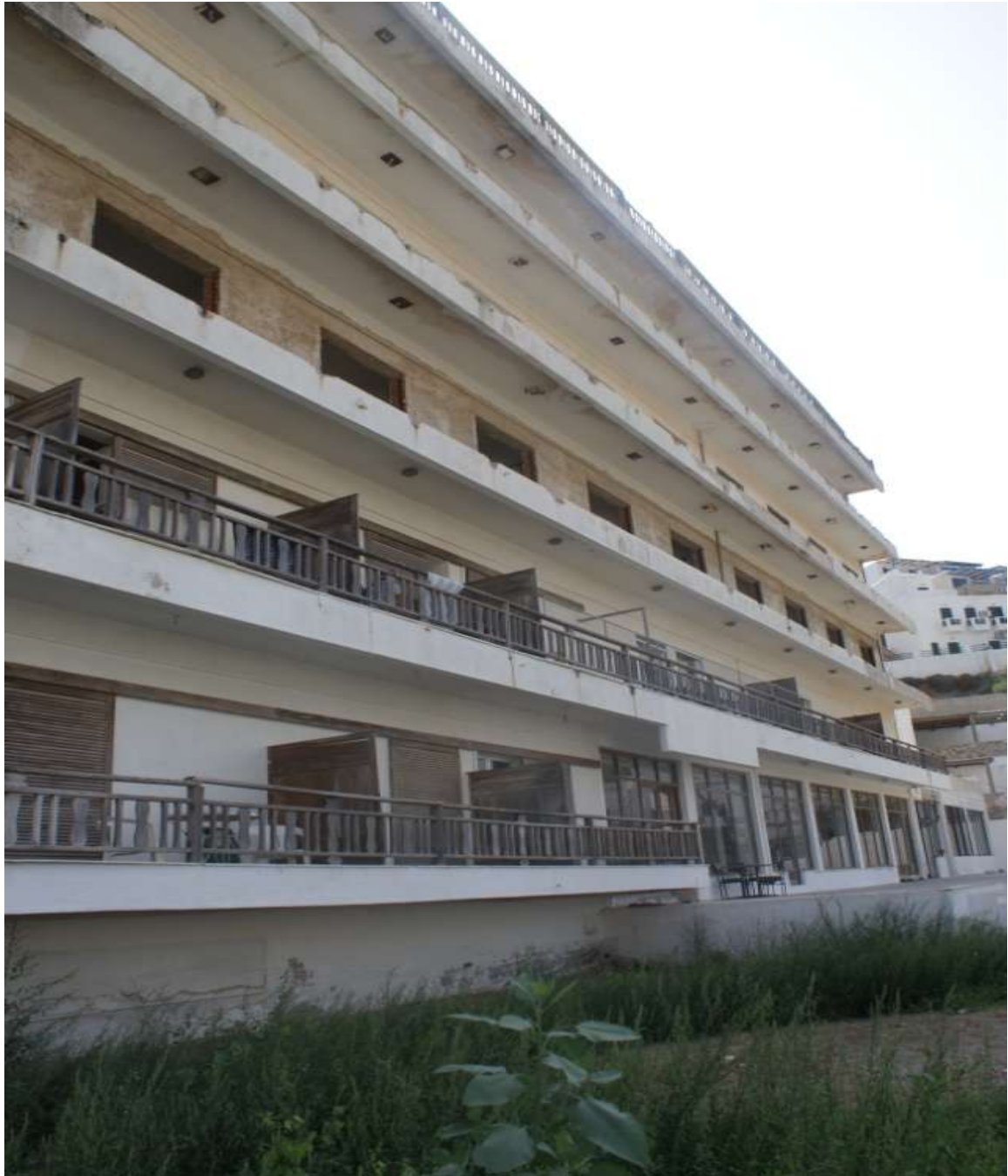
Εικόνα 17 Τα κουφώματα και τα σκίαστρα των διαμερισμάτων καθότι ξύλινα έχουν αποσαθρωθεί.
