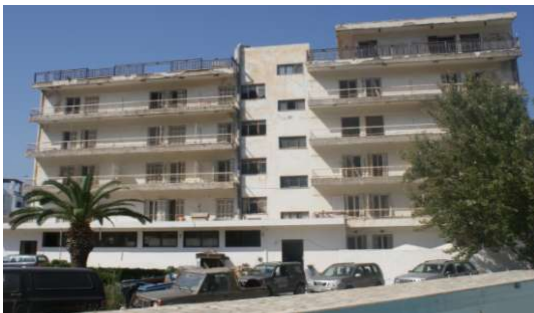
Εικόνα 43 Η νότια πλευρά του κτιρίου
