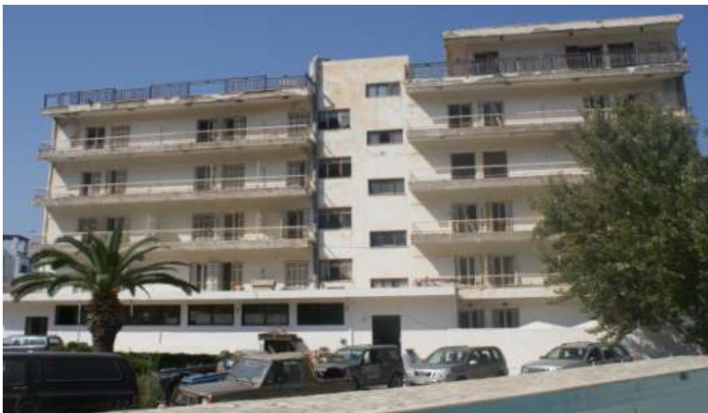
Εικόνα 13 Η νότια πλευρά του ξενοδοχείου
