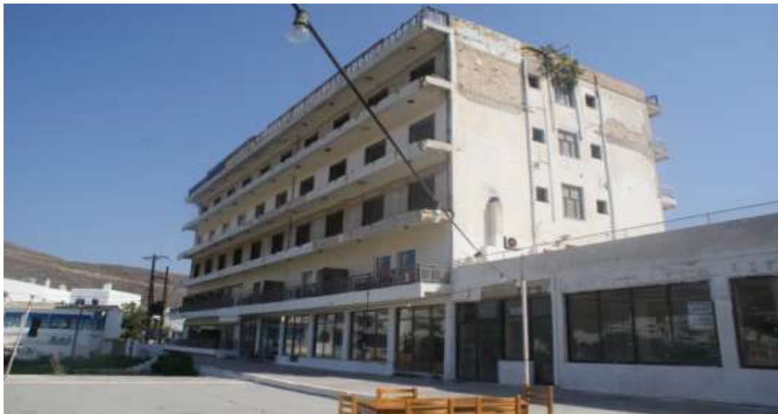
Εικόνα 14 Η δυτική πλευρά του κτιρίου, διαθέτει μικρά ανοίγματα.
