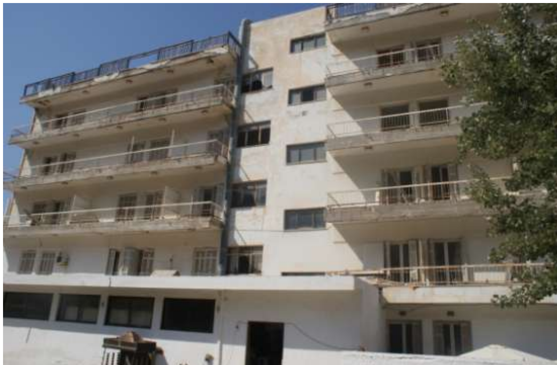
Εικόνα 16 Η νότια πλευρά του κτιρίου
