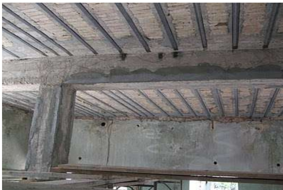
Εικόνα 18 Καμπτική ενίσχυση πλάκας με ανθρακοελάσματα 12
