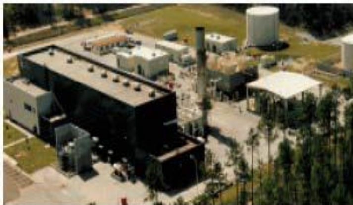
Σχήμα 2.16 Υφιστάμενη μονάδα στην Αλαμπάμα, Αμερική.
