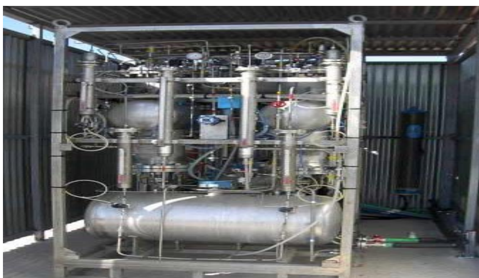
Σχήμα 2.22 Αλκαλική μονάδα ηλεκτρόλυσης 25 kW στο Αιολικό πάρκο του ΚΑΠΕ
