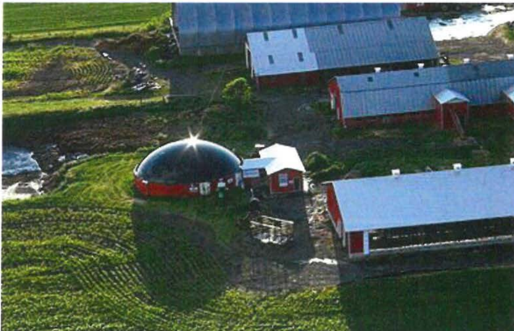
Εικόνα 5.3 Εγκατάσταση παραγωγής βιοαερίου στο Terryland.
