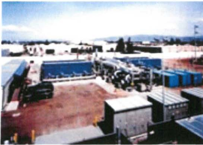
Εικόνα 3.8: Μονάδα κυψελών καυσίμου MCFC, αποτελούμενη από 16 συστοιχίες, συνολικής ισχύος 2 MW, στην Santa Clara της Καλιφόρνια.
