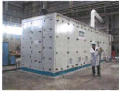
Εικόνα 3.6: Μονάδα SOFC 250 kW ,εγκατεστημένη στην εταιρεία Kinectrics, στο Τορόντο του Καναδά
