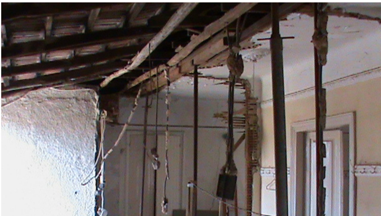
Εικόνα 4: Πλάγια όψη κτιρίου, από την οποία απουσιάζει ο τοίχος
