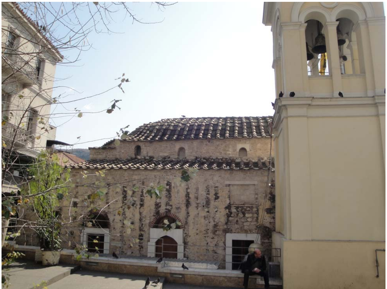
ΕΙΚ.88,89: Βορειανατολική/βόρεια όψη ναού, (Πηγή: Α. Γκιοβάσο)
