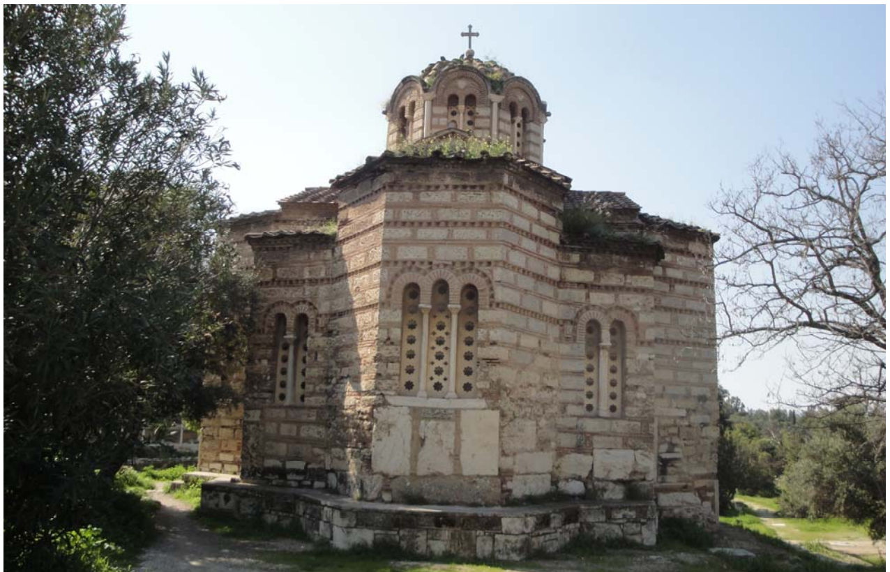
ΕΙΚ.117: Ανατολική όψη ναού, (Πηγή: Α. Γκιοβάσο)
