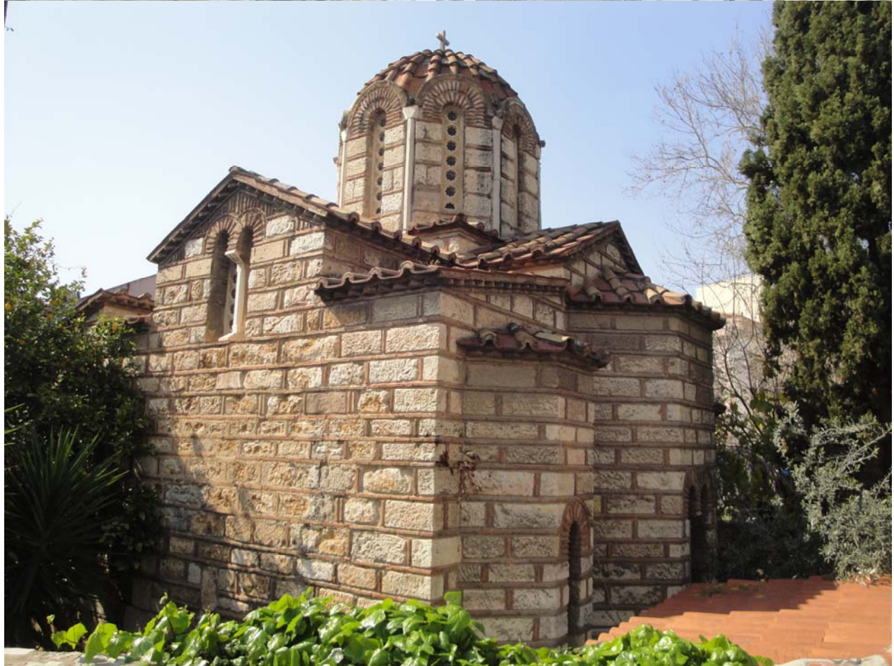
ΕΙΚ.133,134: Δυτική/Νοτιοανατολική όψη ναού, (Πηγή: Α. Γκιοβάσο)
