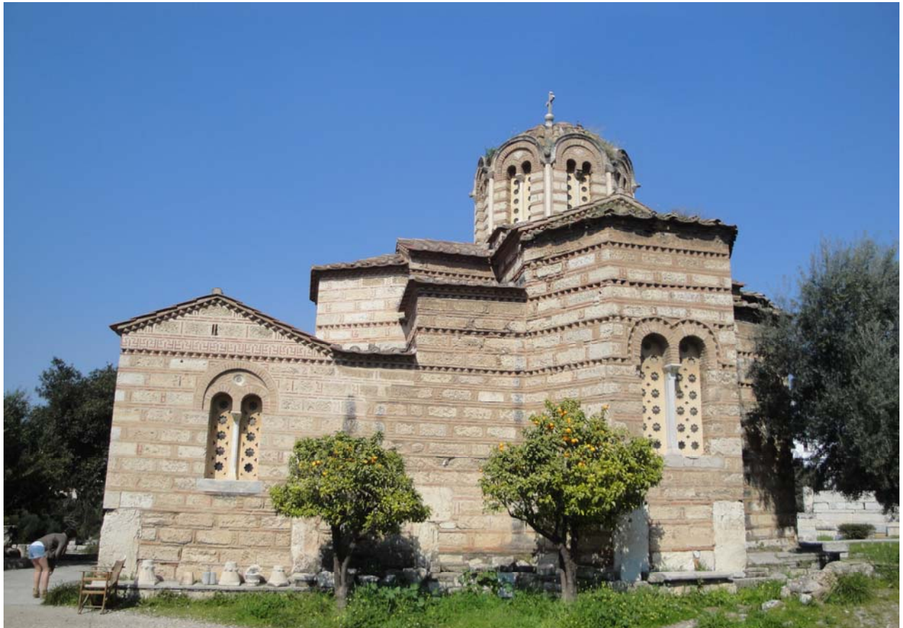
ΕΙΚ.116: Νότια όψη ναού, (Πηγή: Α. Γκιοβάσο)
