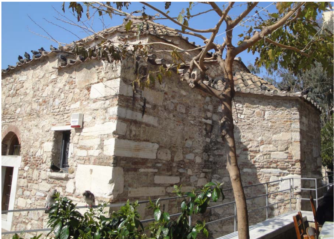
ΕΙΚ.86,87: Νότια/ νοτιοανατολική όψη ναού, (Πηγή: Α. Γκιοβάσο)
