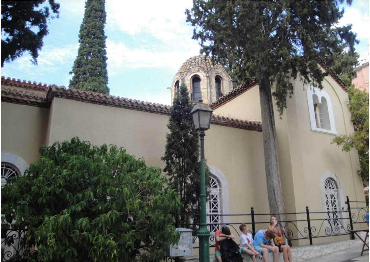
ΕΙΚ.29: Νότια πλευρά ναού (Πηγή: Α. Γκιοβάσο)
