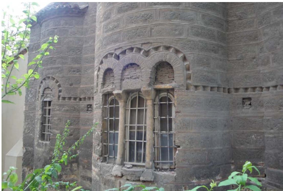
ΕΙΚ.33: Ανατολική πλευρά ναού (Πηγή: Α. Γκιοβάσο)
