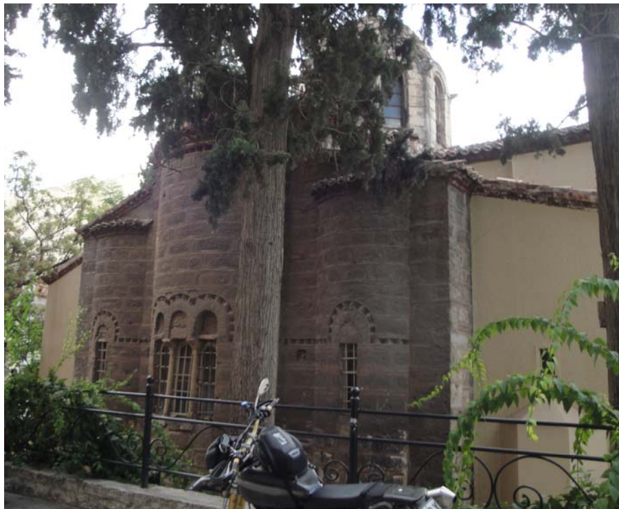
ΕΙΚ.31,32: Ανατολική πλευρά ναού (Πηγή: Α. Γκιοβάσο)
