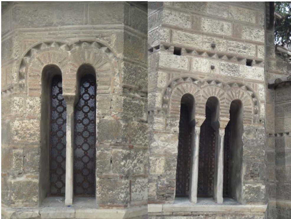
ΕΙΚ.92,93: Δίλοβα /Τρίλοβα παράθυρα της κόγχης του ιερού ανατολική πλευρά του ναού, (Πηγή: Α. Γκιοβάσο)
