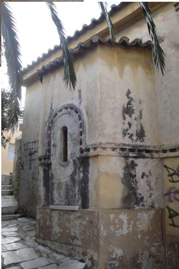
ΕΙΚ.46,47: Ανατολική όψη, λίθινη αντηρίδα/ κόγχη ιερού ανατολική όψη, (Πηγή: Α. Γκιοβάσο)
