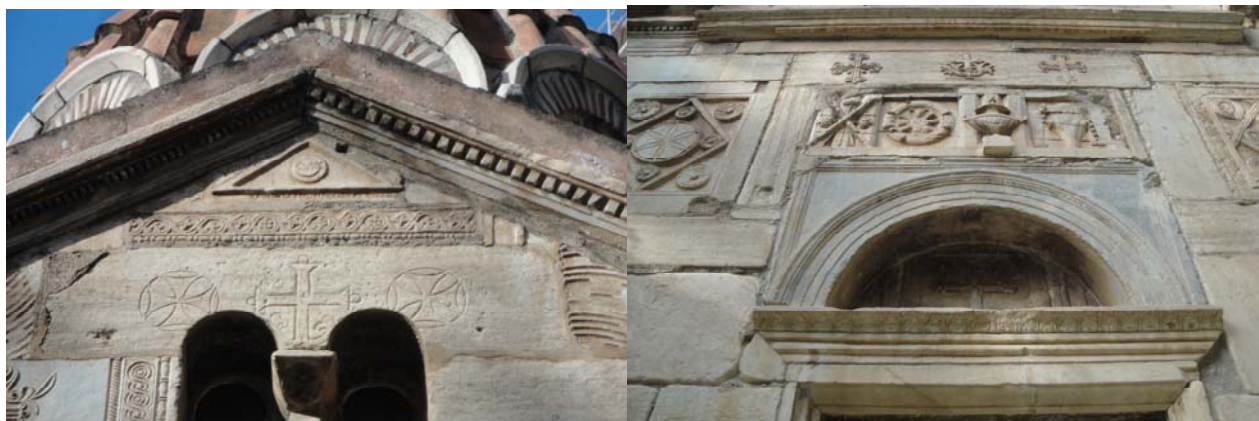
ΕΙΚ.82,83: Νότια όψη ναού,(Πηγή: Α. Γκιοβάσο)
