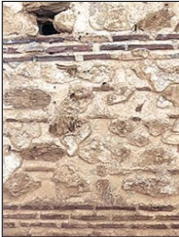
Εικ. 50: Τύπος τοιχοποιίας, όπου η απλή λιθοδομή εναλλάσσεται με ζώνες πλίνθων. Ναός Της Οδηγήτριας. Πηγή: 5 η Εφορεία Βυζαντινών Αρχαιοτήτων
