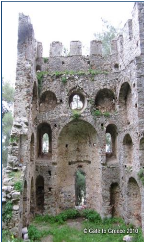
Εικ.84: Το εσωτερικό του Πύργου της Τράπεζας Νότια της Περίβλεπτου. Πηγή: panoramio.com.
