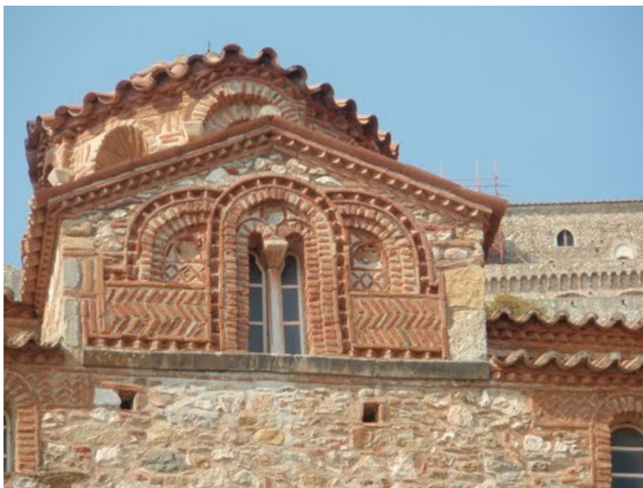
Εικ. 92: Λεπτομέρεια τοιχοποιίας. Βόρεια Όψη του Ναού της Ευαγγελίστριας. Πηγή: panoramio.com.
