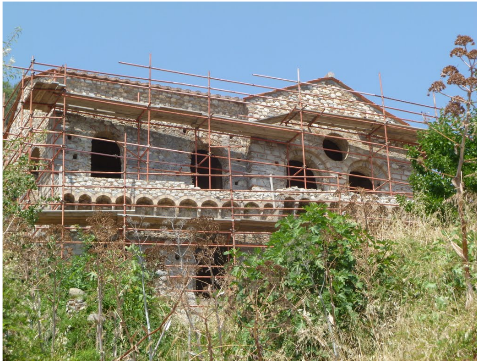
Εικ.117. Οικία Λάσκαρη. Ανατολική Όψη. Πηγή: Γαλανού Κατερίνα.
