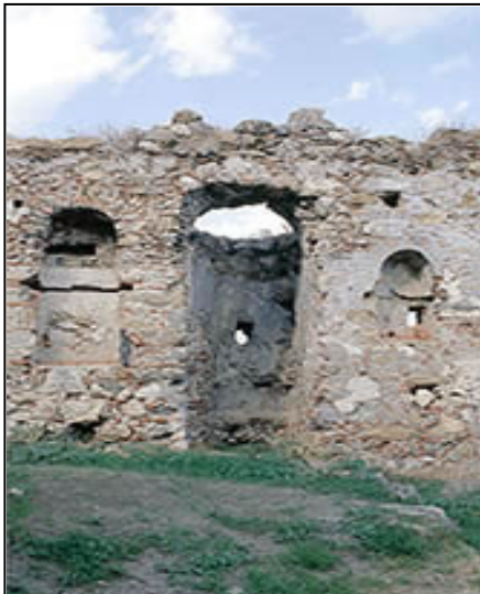
Εικ. 11: Αποχωρητήριο Μυστριώτικης οικίας, που διαθέτει σπή φωτισμού και αερισμού. Πηγή: 5 η Εφορεία Βυζαντινών Αρχαιοτήτων.
