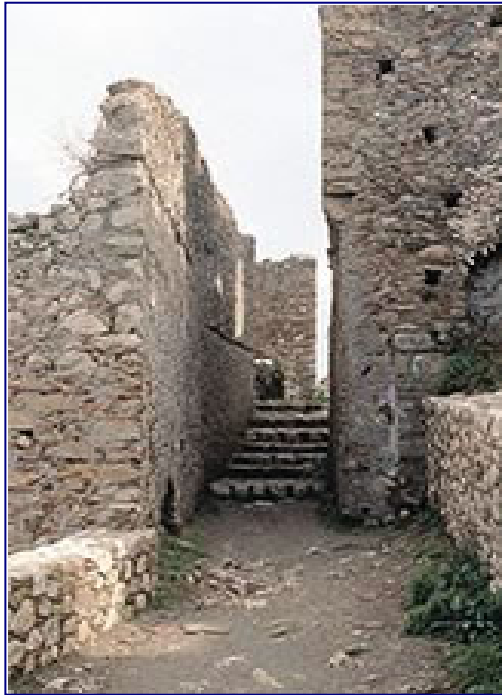
Εικ.7: Οι «φαλτσογωνίες» στα ισόγεια των κτιρίων διευκολύνουν τη διακίνηση των αγαθών. Πηγή: 5 η Εφορεία Βυζαντινών Αρχαιοτήτων
