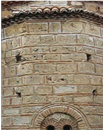
Εικ.72: Το πλινθοπερίκλειστο σύστημα τοιχοποιίας. 1250-1265, Αγία Σοφία, Πηγή: 5 η Εφορεία Βυζαντινών Αρχαιοτήτων
