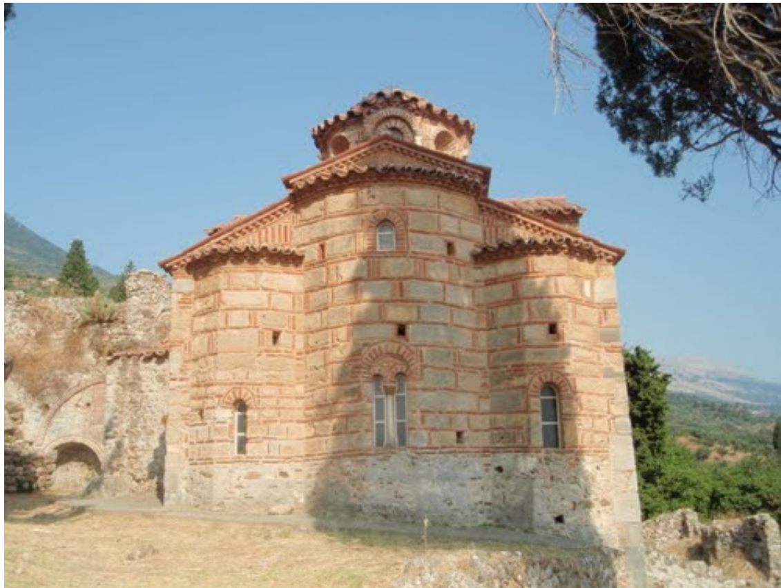
Εικ. 93: Ανατολική Όψη του Ναού της Ευαγγελίστριας. Πηγή: panoramio.com.
