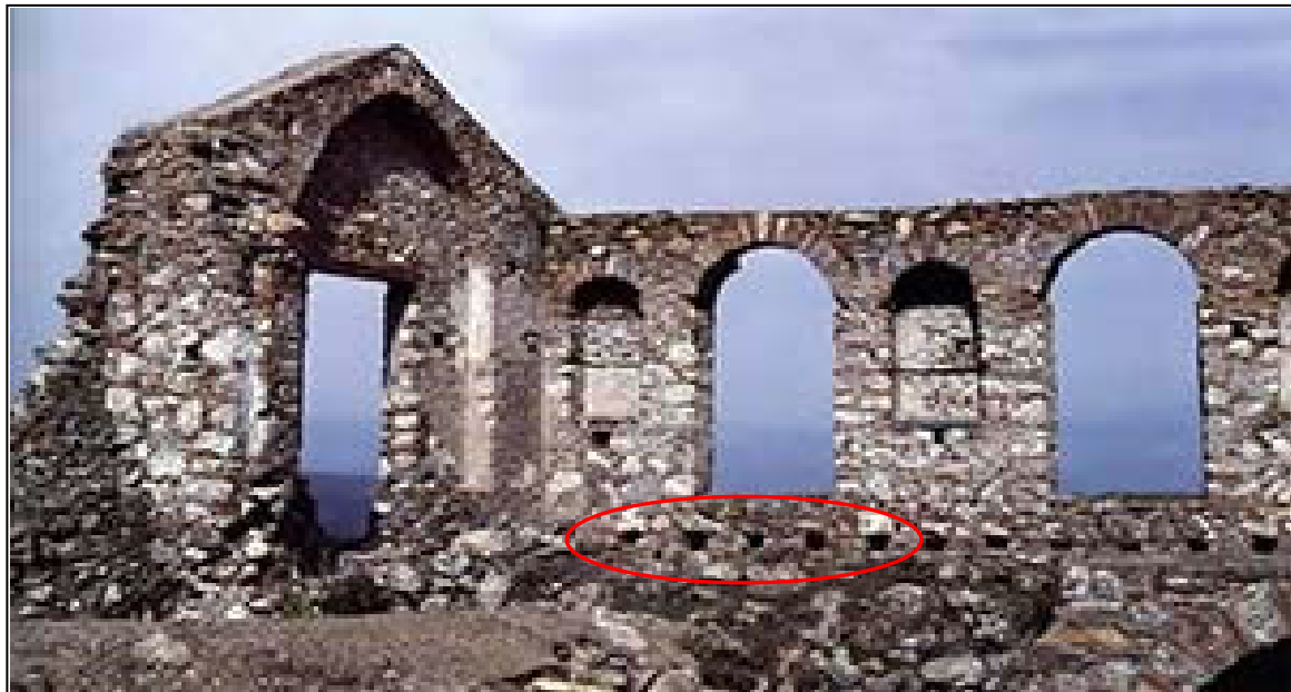
Εικ. 14: Δοκοθήκες: οπές στους τοίχους, όπου στερεώνονταν μεγάλα δοκάρια, πάνω στα οποία τοποθετούνταν τα ξύλινα πατώματα.
