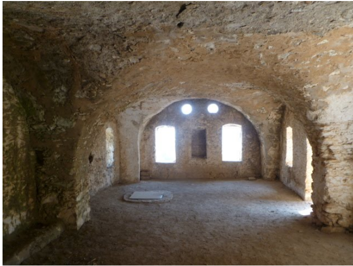
Εικ. 17α: Ισόγειο οικίας "Φραγκόπουλου". Πηγή: Γαλανού Κατερίνα.
