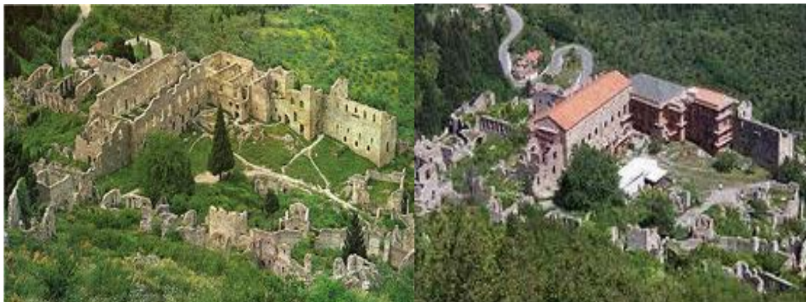
Εικ.118. Άποψη των παλατιών του Μυστρά, πριν και μετά την αναστύλωση. Πηγή: 5 η Εφορεία Βυζαντινών Αρχαιοτήτων.
