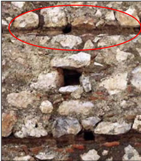
Εικ. 15: Αποτυπώματα ξυλοδεσιών για την ενίσχυση της τοιχοποιίας.
