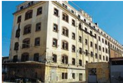
Εικόνα Π.1.2: εγκαταλελειμμένο κτήριο των Μύλων Αλλατίνη
