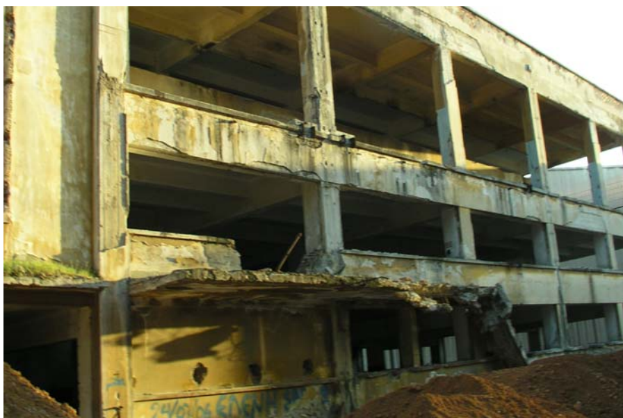
Εικόνα ΠΙ.Β.4 : κατάσταση δεξαμενής
