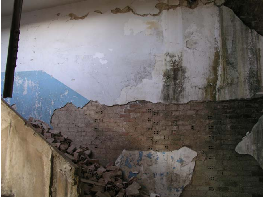
Εικόνα III.B.1.1 : άποψη τοιχοποιίας στο εσωτερικό της σκάλας
