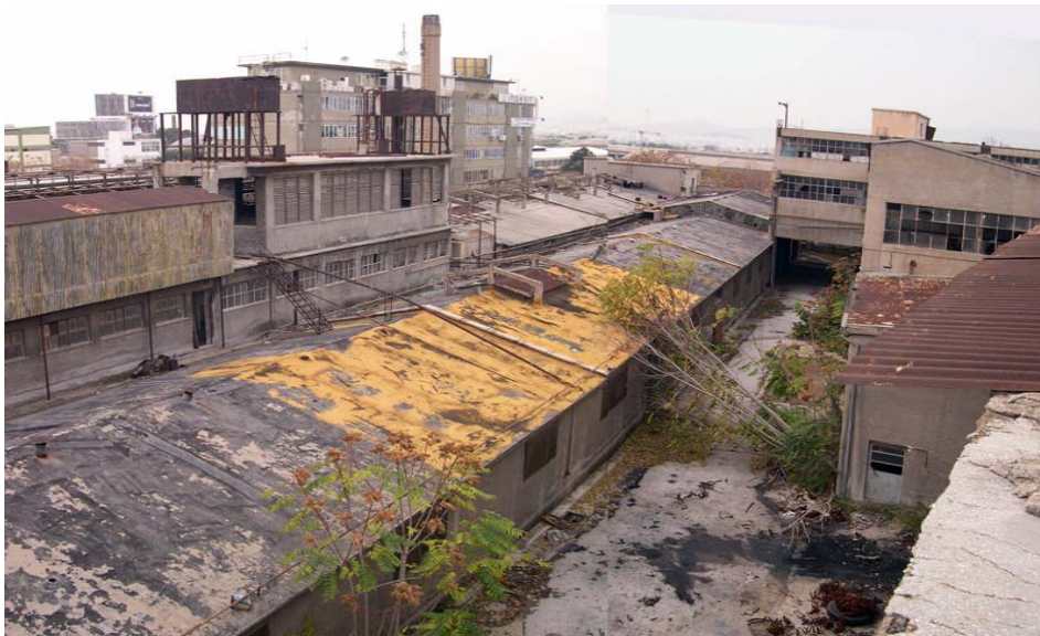
Εικόνα II.1 : Εγκαταλελειμμένο σύμπλεγμα βιομηχανικών κτηρίων στην Πειραιώς
