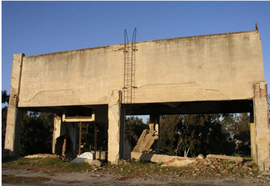
Εικόνα ΠΙ.Β.3 : κατάσταση δεξαμενής
