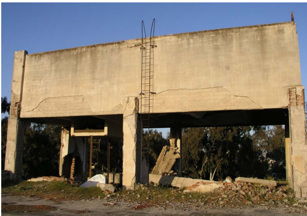
Εικόνα III.A.5 : δεξαμενή στην ταράτσα
