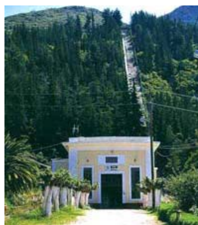
Εικόνα Π.1.5 : Υ/Η Σταθμός Γλαύκου
