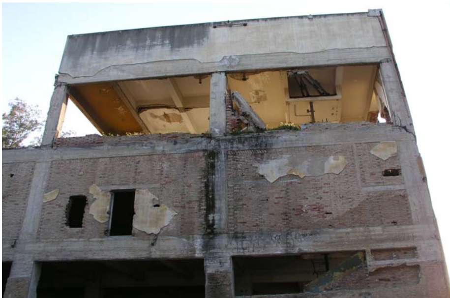
Εικόνα III.B.1.2 : ανατολική πλευρά, εξωτερική τοιχοποιία
