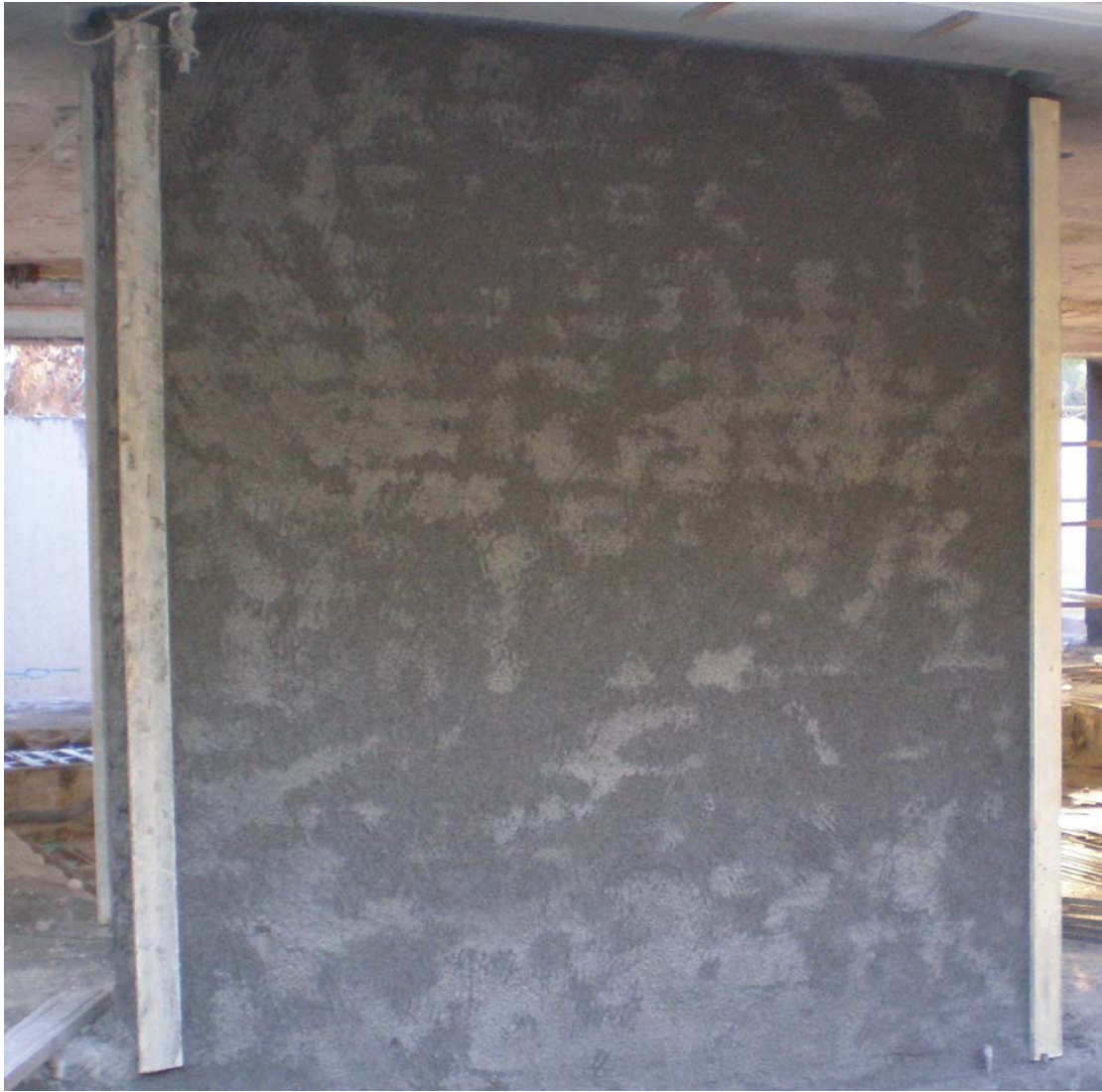
Εικ. 78 Το τοίχωμα μετά την ενίσχυση
