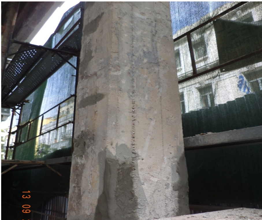
Εικ. 40 Υποστύλωμα πριν τη τοποθέτηση μεταλλικού κλωβού
