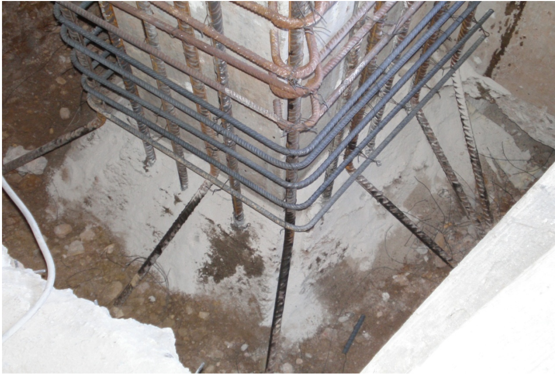
Εικ. 2 Πέδιλο πριν την τοποθέτηση του μανδύα φωτογραφία αρχείο Exinos Constructions
