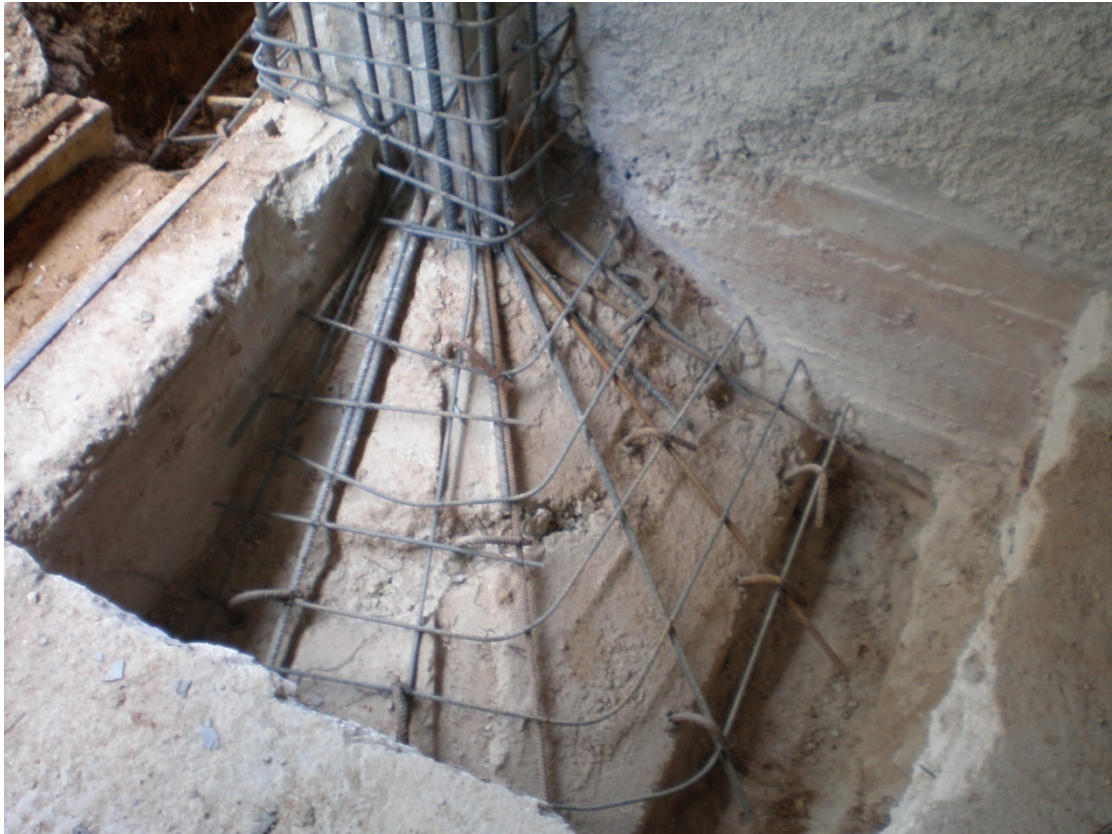
Εικ.5 Γωνιακό πέδιλο με μανδύα και βλύτρα
