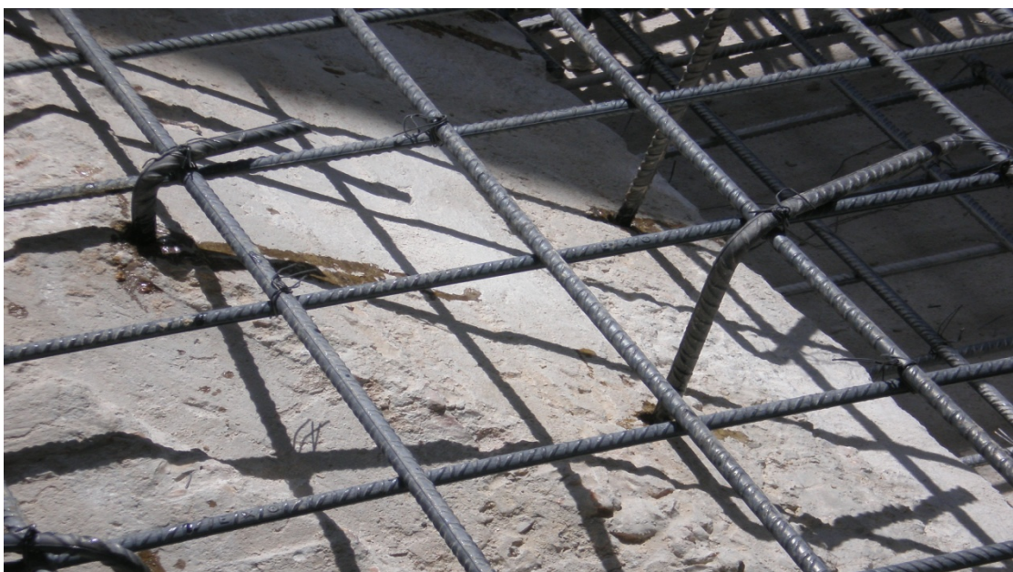
Λεπτομέρεια τοποθέτησης βλύτρων στο πέδιλο
