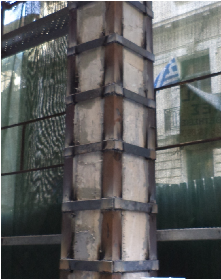
Εικ. 46 Ο μεταλλικός κλωβός μετά τις εργασίες τοποθέτησης
