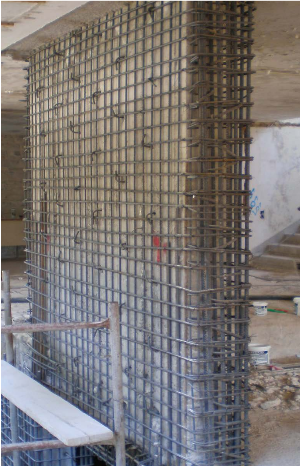
Εικ. 76 τοίχωμα ενισχυμένο με κλειστό μανδύα
