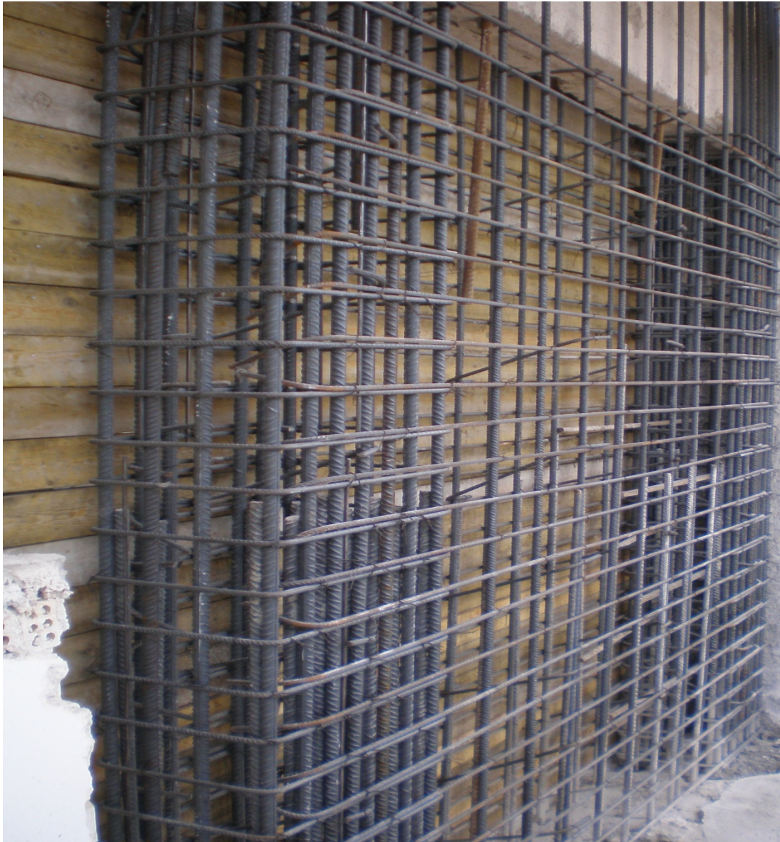
Εικ. 77 Το τοίχωμα μετά την τοποθέτηση του ξυλοτύπου φωτογραφία αρχείο Exinos Construction
