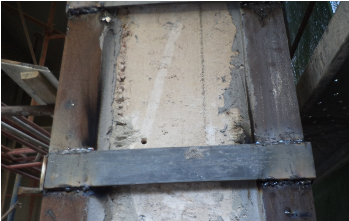
Εικ. 47 Λεπτομέρεια μεταλλικού κλωβού
