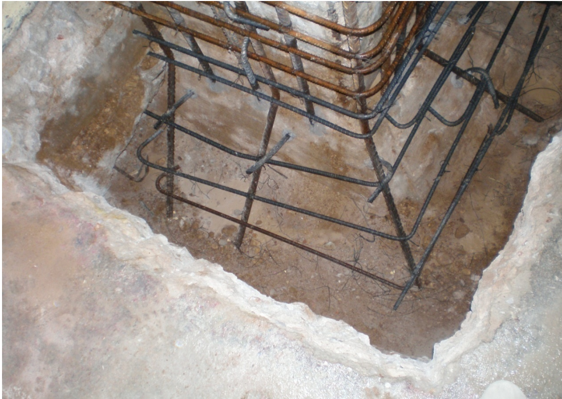
Εικ.4 Πέδιλο με μανδύα και βλύτρα
