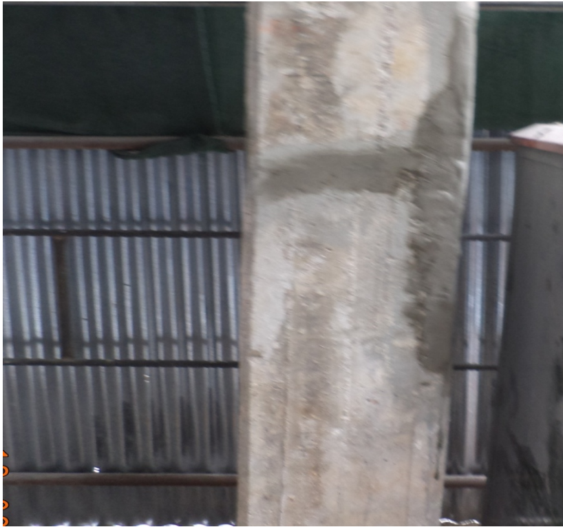
Εικ. 39 Υποστύλωμα πριν τη τοποθέτηση μεταλλικού κλωβού
