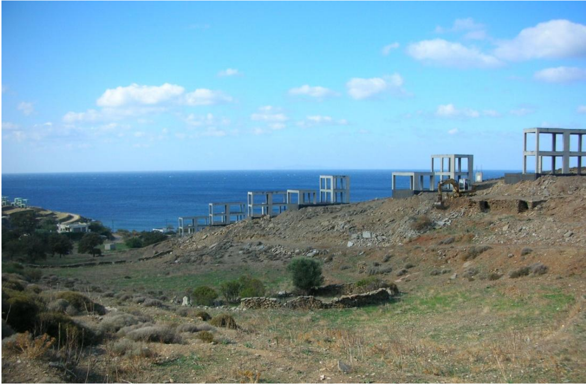
Βορειοανατολική όψη του συγκροτήματος.
