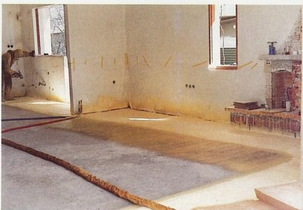
Μόνωση εσωτερικού χώρου πυλωτής με SPRAY Πολυουρεθάνης
