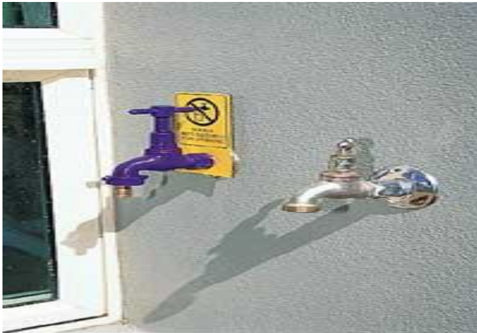
Εικόνα 20 ΔΙΚΤΥΟ ΗΜΙΑΚΑΘΑΡΤΩΝ ΝΕΡΩΝ
