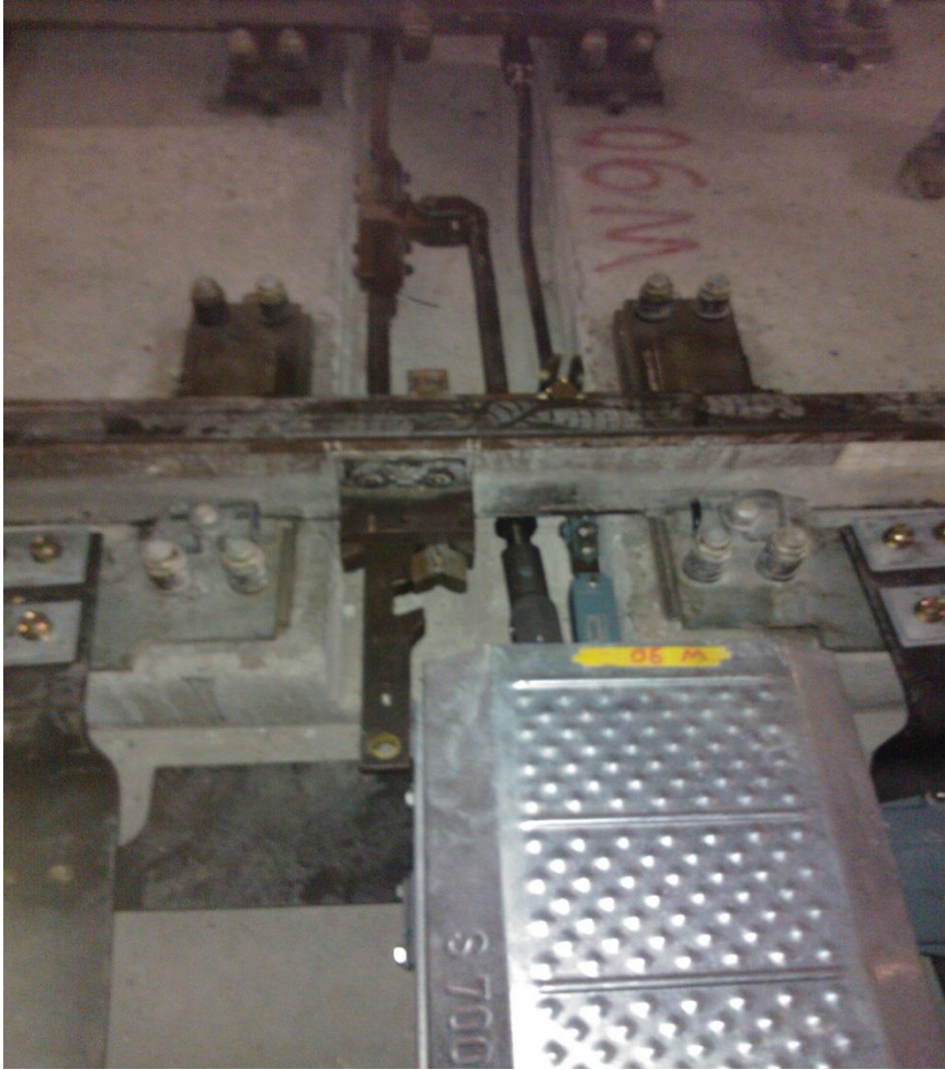
Εικόνα 39: Ηλεκτροκίνητο χειριστήριο αλλαγής τροχιάς σε αλλαγή τροχιάς με χελιδνοσουρά
