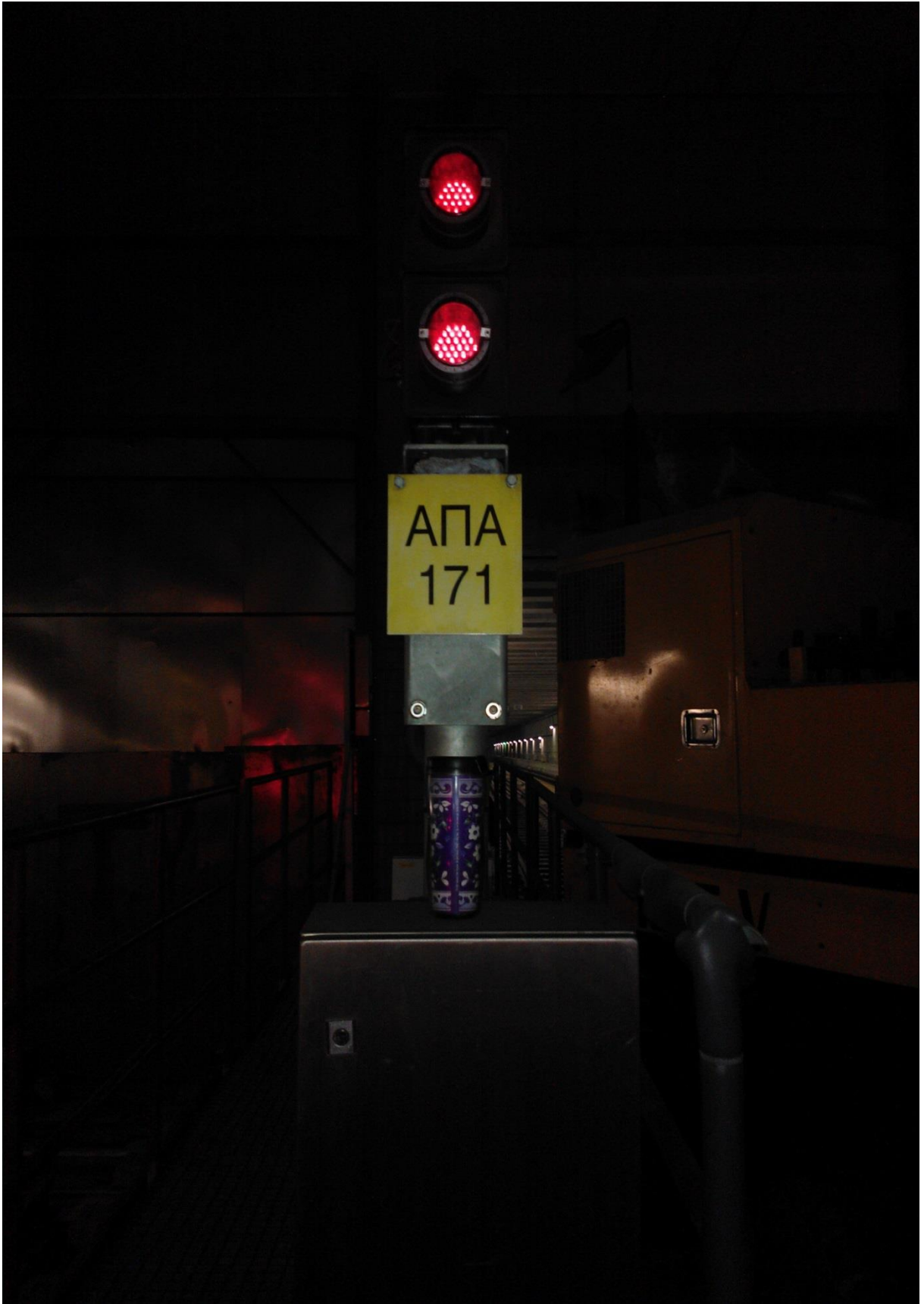
Εικόνα 35: Κιβώτιο Ελέγχου και Φωτόσημα στο Τέρμα της Γραμμής
