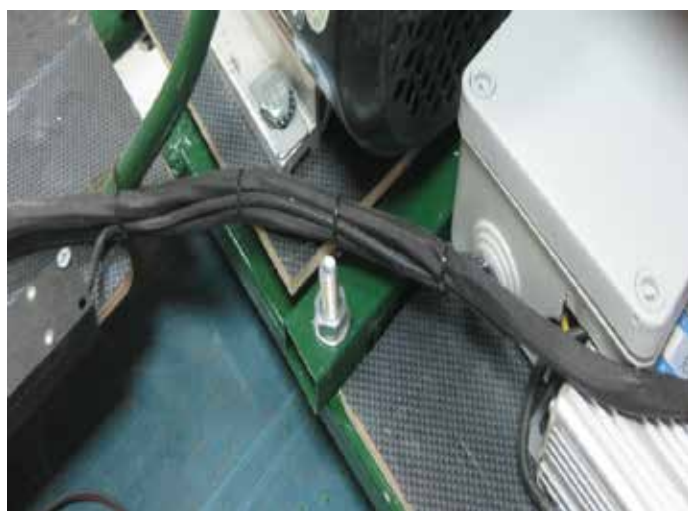
ΤΟΠΟΘΕΤΗΣΗ ΤΩΝ ΚΑΛΩΔΙΩΝ ΠΡΟΣ ΤΟΝ ΠΙΝΑΚΑ ΕΛΕΓΧΟΥ
