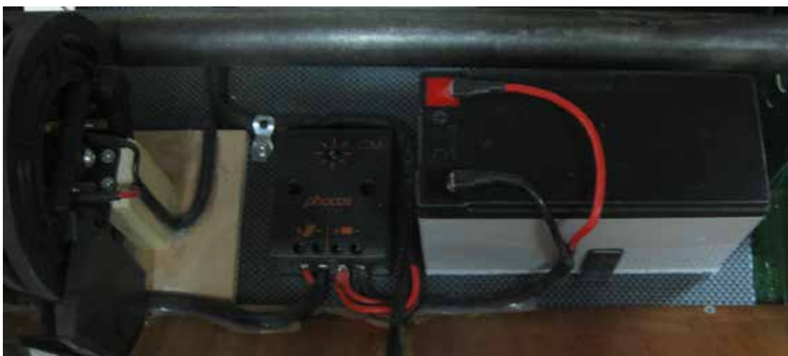
ΤΟΠΟΘΕΤΗΣΗ ΤΟΥ ΡΥΘΜΙΣΤΗ ΦΟΡΤΙΣΗΣ ΚΑΙ ΣΥΣΣΩΡΕΥΤΗ ΦΩΤΙΣΜΟΥ 12V
