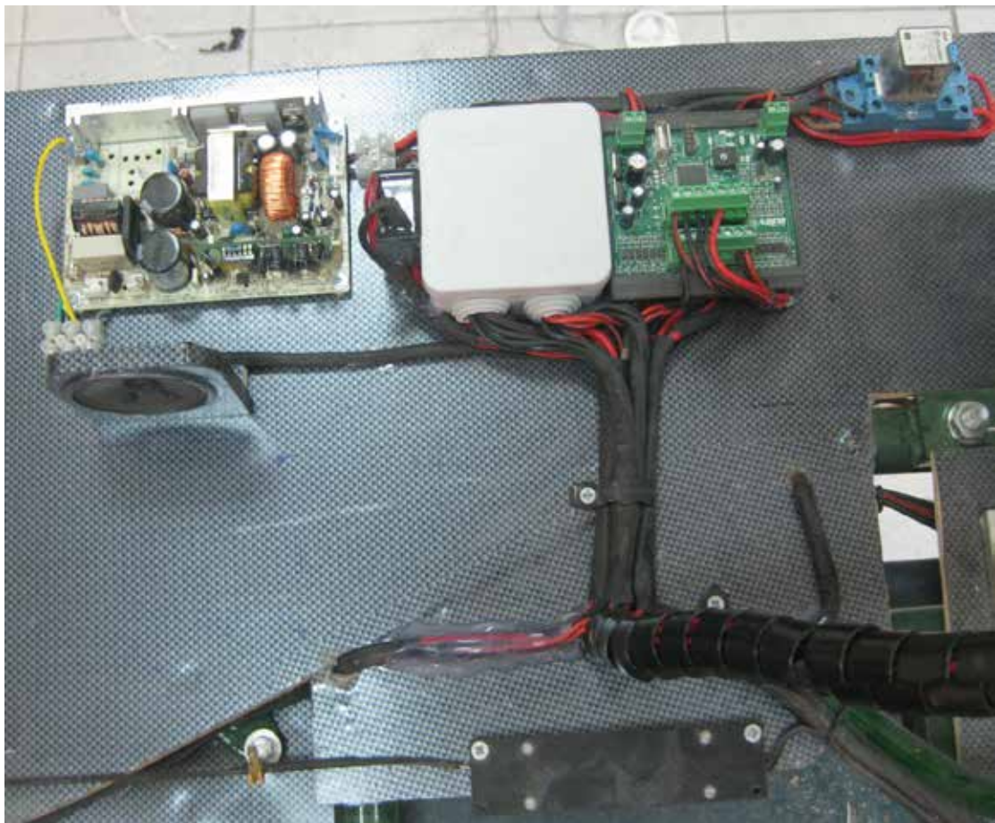
ΟΛΟΚΛΗΡΩΣΗ ΤΗΣ ΚΑΛΩΔΙΩΣΗΣ ΚΑΙ ΤΗΣ ΠΛΕΞΟΥΔΑΣ ΠΡΟΣ ΤΟΝ ΠΙΝΑΚΑ ΕΛΕΓΧΟΥ
