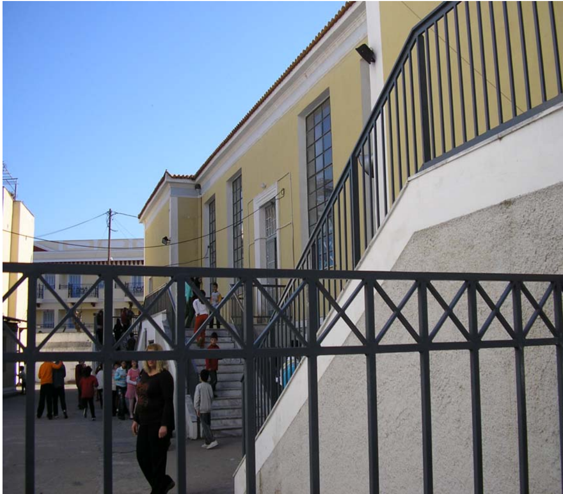
Δυτική όψη, μετά την αποκατάσταση (Φώτο, 2000)
