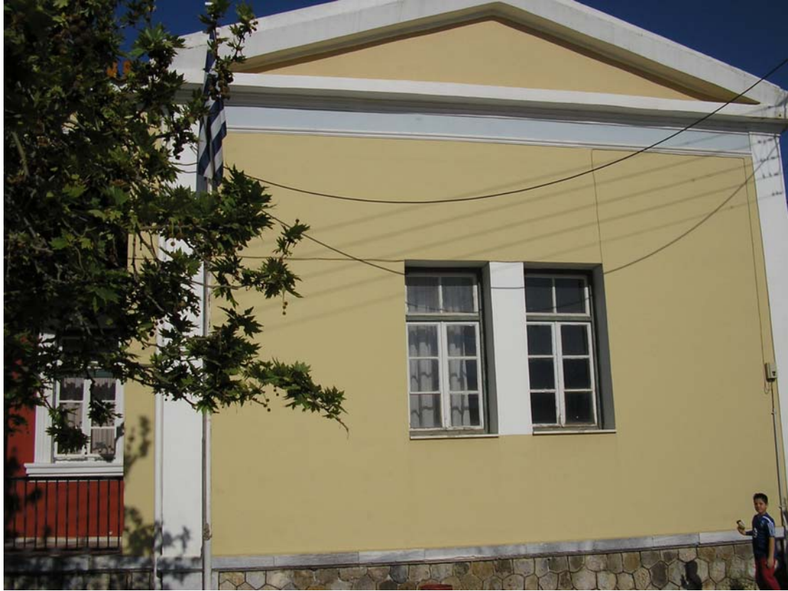
Βόρεια όψη, μετά την αποκατάσταση (Φώτο,2000)
