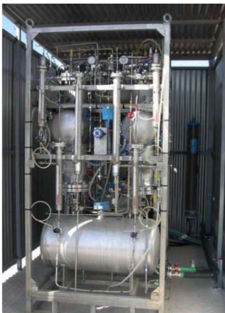
Εικόνα 1. Η αλκαλική μονάδα ηλεκτρόλυσης 25 kW, δυνατότητας παραγωγής 0.45 kg/h
