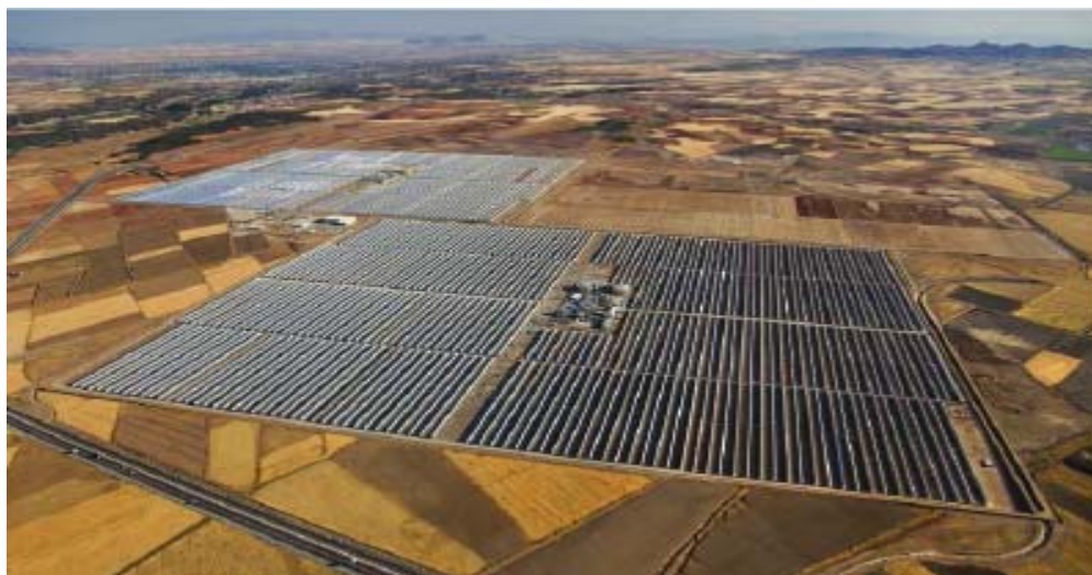
Σχήμα 2.7 Οι ηλιοθερμικοί σταθμοί παραβολικών κατόπτρων Andasol 1 (μπροστά) και Andasol 2 (πίσω) στην Ισπανία. Ο σταθμός παραγωγής ισχύος και το σύστημα αποθήκευσης θερμότητας βρίσκονται στο κέντρο καθενός ηλιακού πεδίου [26]
