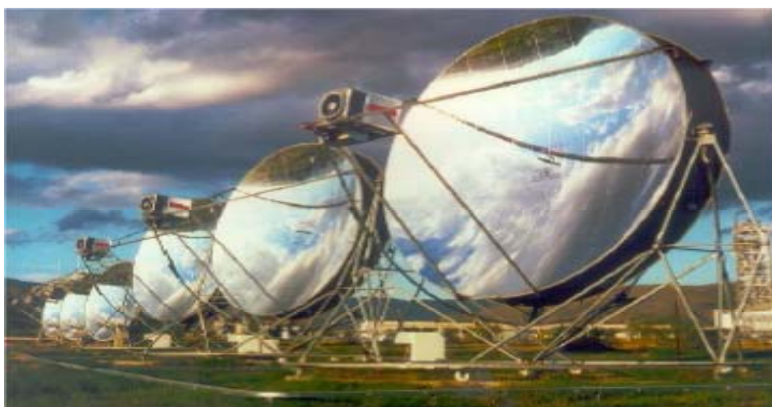
Σχήμα 2.13 Έξι παραβολικοί δίσκοι με μηχανές Stirling σε λειτουργία στο ερευνητικό κέντρο Plataforma Solar de Almeria της Ισπανίας. Κάθε δίσκος παράγει 10kW ηλεκτρικής ισχύος.
