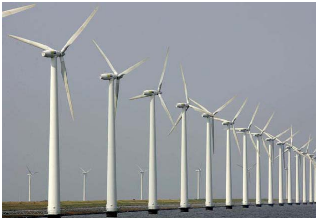
Σχήμα 9: Ανεμογεννήτριες με χαλύβδινους σωληνοειδείς πύργους
