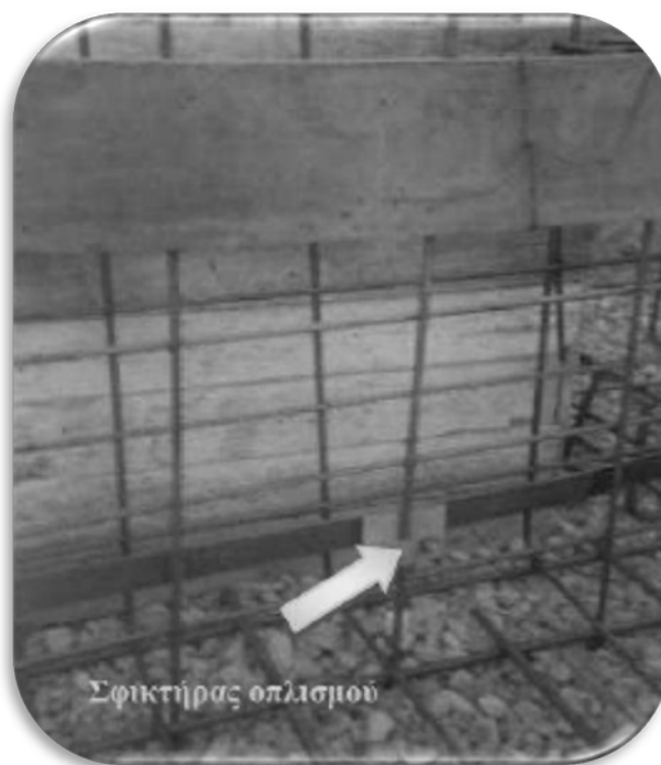
Σχήμα 2.4 Σφικτήρας οπλισμού
