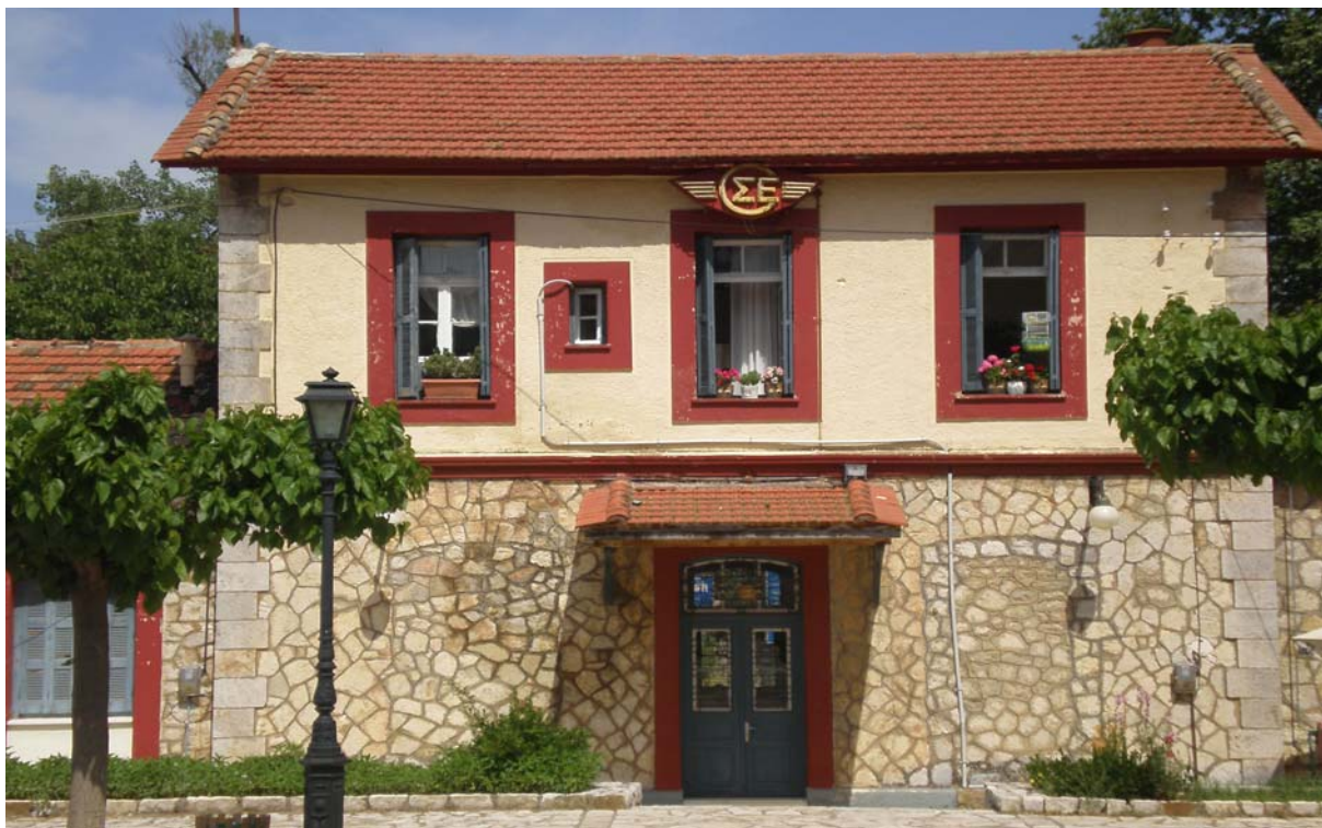
Εικόνα 68 <Η μπροστινή όψη του κεντρικού κτιρίου του Σ.Σ Καλαβρύτων>
