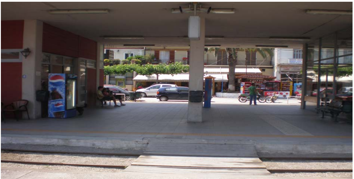
Εικόνα 77 <Το δάπεδο του σταθμού>
