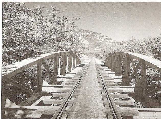
Μεταλλική τόξοτη γέφυρα στο χμ. 16,9
