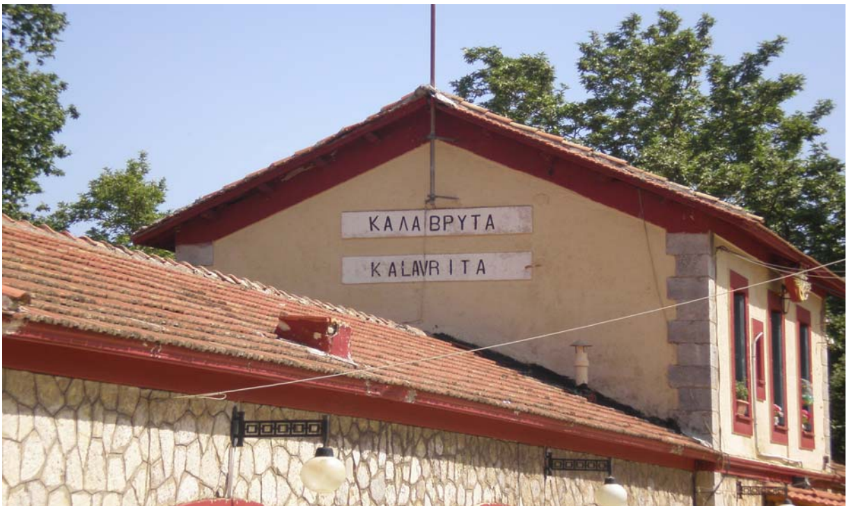
Εικόνα 73 <Η κεραμοσκεπή των κτιρίων>
