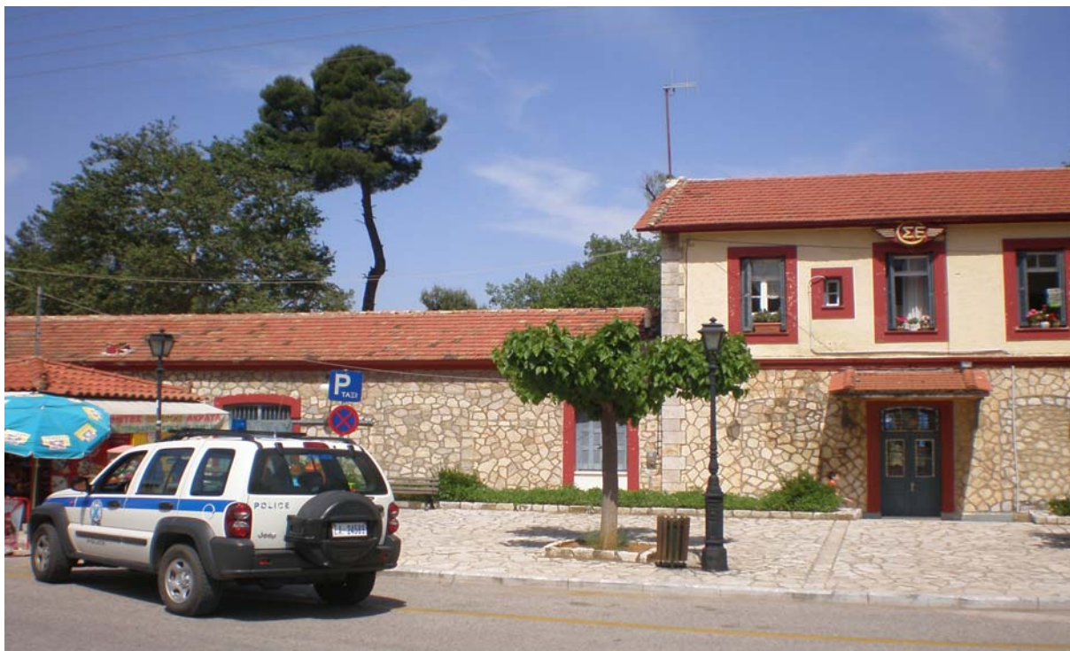
Εικόνα 69 <Η τοιχοποιία και τα ανοίγματα στα κτίρια του σταθμού>
