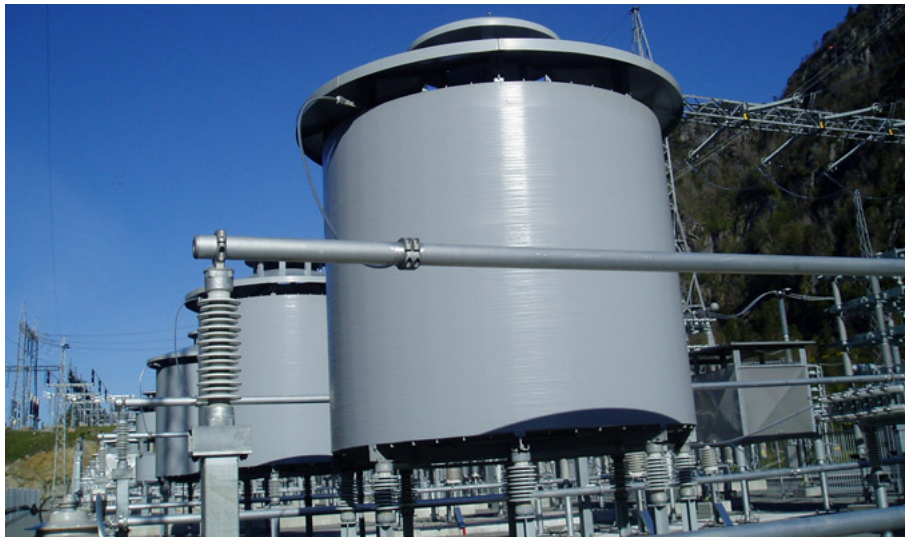
Σχήμα 4.12 AC φίλτρο
