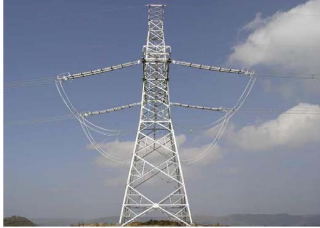
Σχήμα 3.9 Διπολικός πύλωνας HVDC 500KV
