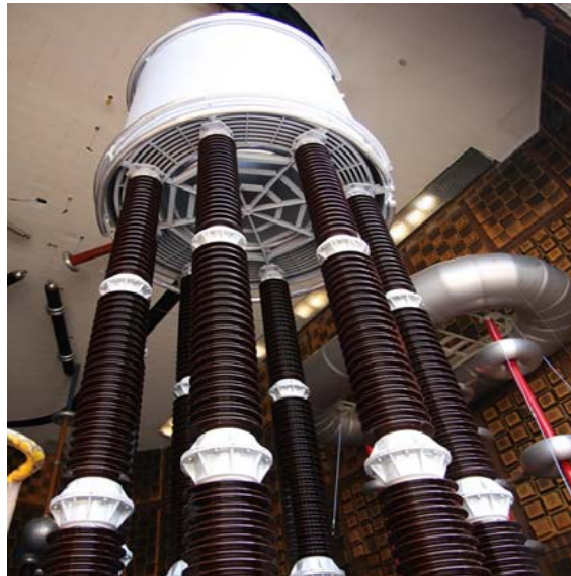
Σχήμα 4.16 Αυτεπαγωγή εξομάλυνσης ξηρού τύπου
