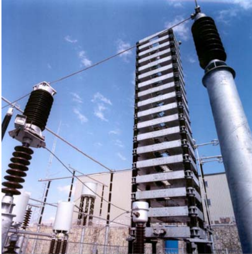
Σχήμα 4.13 DC φίλτρο
