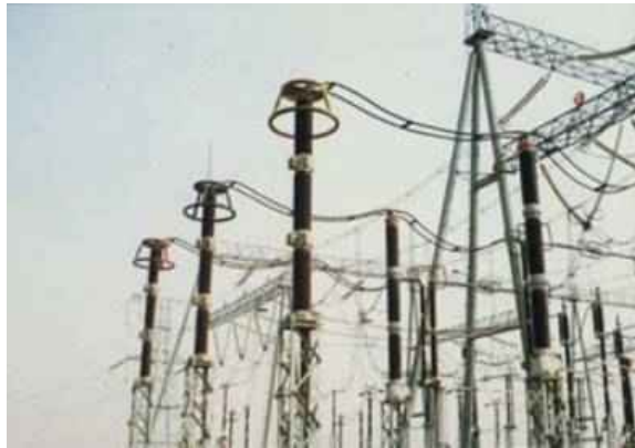
Σχήμα 4.18 Απαγωγοί υπερτάσεων σε HVDC σύστημα
