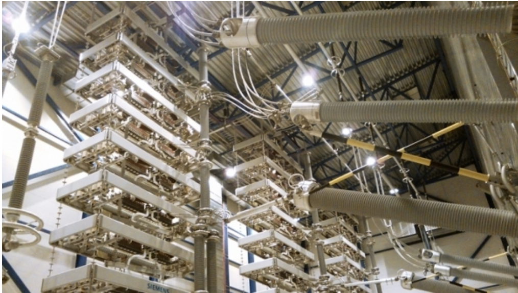
Σχήμα 4.5 Γέφυρα 12-πάλμων με Θυρίστορ
