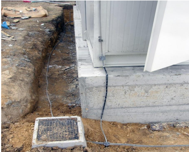
Εικόνα 2.18 Κατασκευή γείωσης Υποσταθμού
