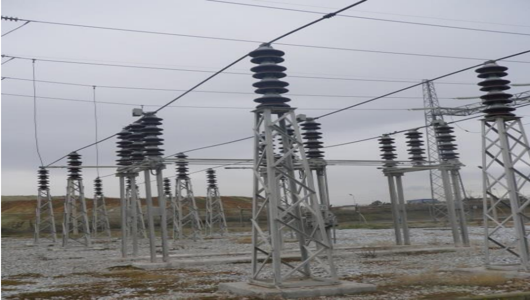
Σχήμα 2.4 : Αποζεύκτες και γειωτές Υποσταθμού [6]
