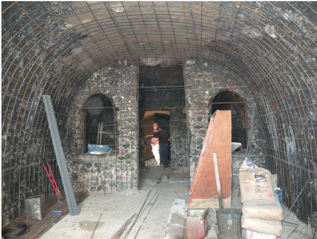
Εικ. 20: Σιδέρωμα του εσωτερικού του υπόσκαφου. 2ο στάδιο (Πηγή: Προσωπικό αρχείο Αρχιτέκτονα Σταύρου Κουταλίδη )
