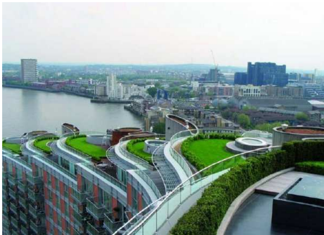
Εικ.23 : Φυτεμένο δώμα (Πηγή: Διαδίκτυο)
