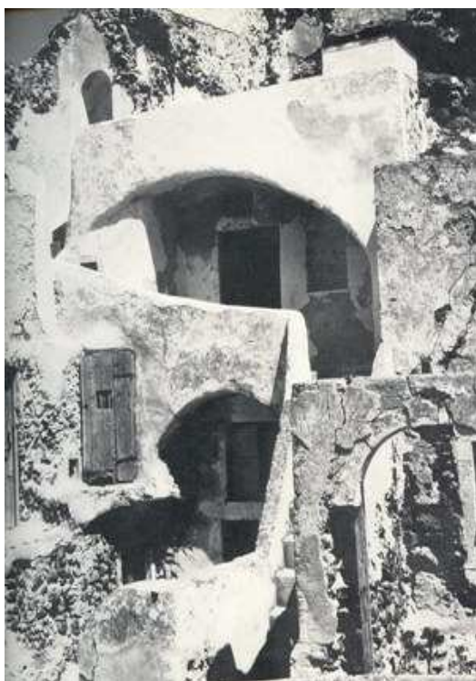
Εικ.:12:Οία .Αποψη συγκροτήματος κατοικιών, όπου φαίνεται καθαρά η αλληλοδιείσδυση των όγκων στην προσπάθεια εξοικονόμησης χώρου. (Πηγή: Μέλισσα)
