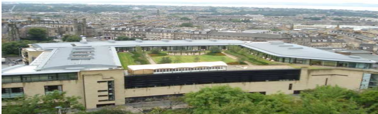
Εικ.28: Φυτεμένο Δώμα (Πηγή: Διαδίκτυο)
