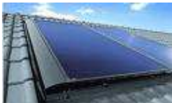
Εικ.36: Μορφή ηλιακού θερμοσίφωνα σε στέγη. (Πηγή : nraikos.gr/wp-content/uploads/2008/02/iliakos.jpg)
