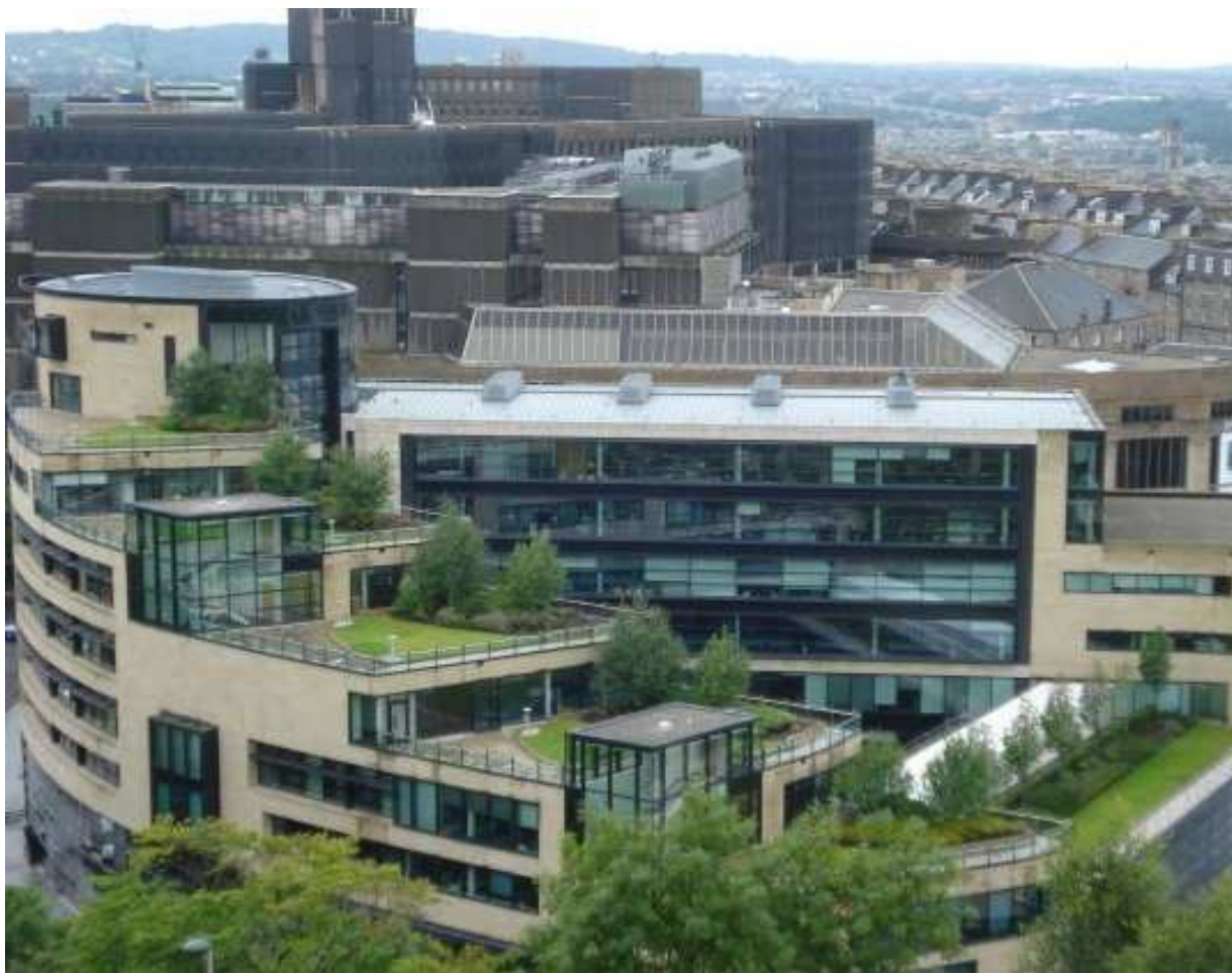
Εικ.27: Φυτεμένες οροφές σε κτίριο γραφείου. (Πηγή: Διαδίκτυο)
