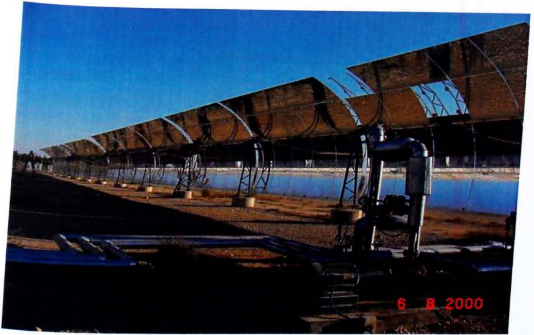
Εικ 4.3: Σύνδεση κυρτών συλλεκτών με το δίκτυο ύδρευσης [23]
