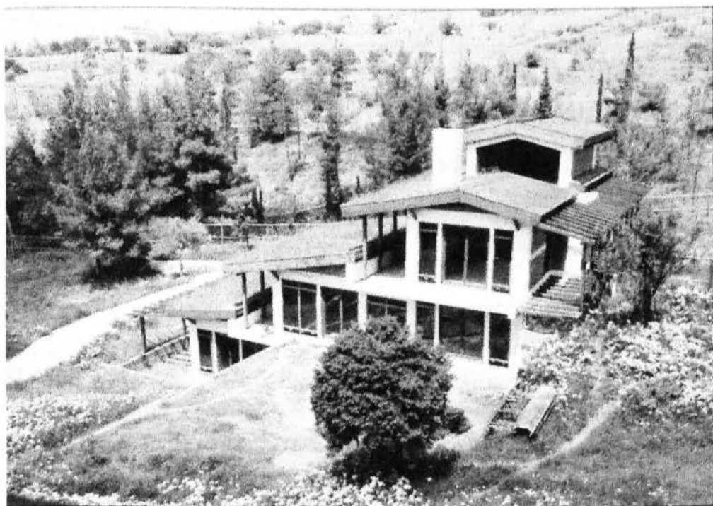
Εικόνα 25: Νότια όψη οικίας
