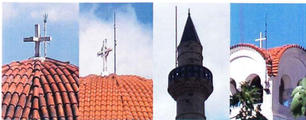
Αλεξικέραυνα σε τρούλους, μιναρέ και καμπαναριό.
