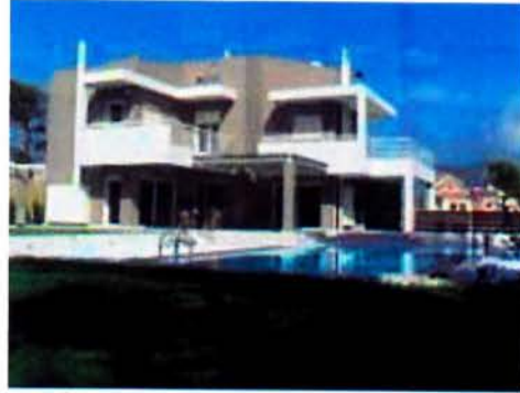
Σχήμα 18: Εγκατάσταση γεωθερμικής εφαρμογής
