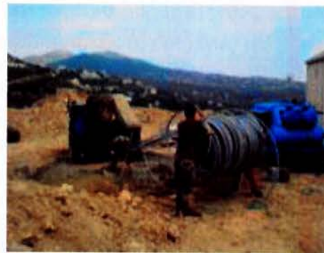
Σχήμα 21: Τοποθέτηση σωλήνων κατακόρυφου γεωεναλλάκτη σε γεώτρηση
