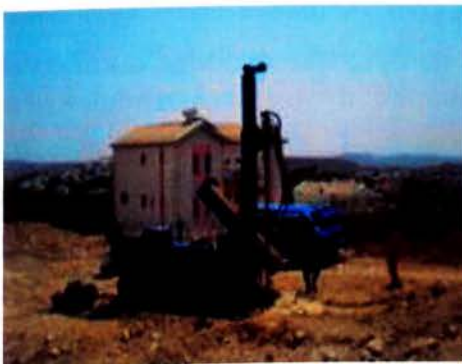
Σχήμα 20: Γεώτρηση για τοποθέτηση κατακόρυφου γεωεναλλάκτη
