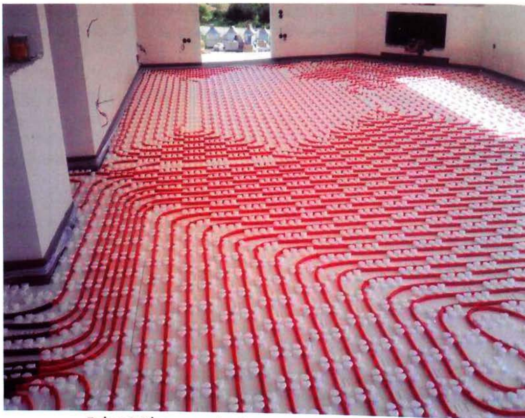
Σχήμα 8: Σύστημα σωληνώσεων ενδοδαπέδιας θέρμανσης
