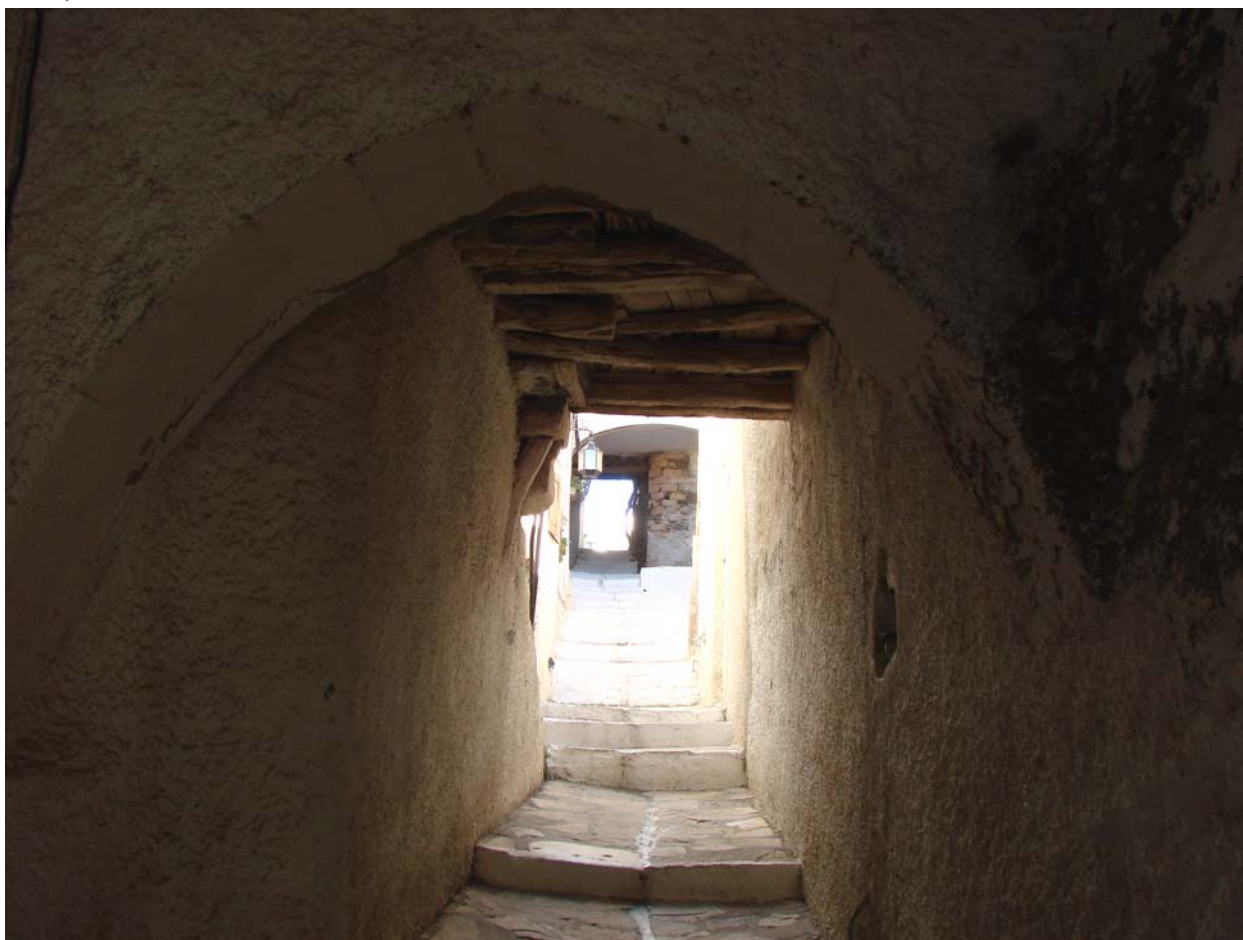
Εικ.25- Στεγαστό όπου φαίνεται η ξύλινη φέρουσα κατασκευή και η τοξωτή όψη (οξυκόρυφη)
