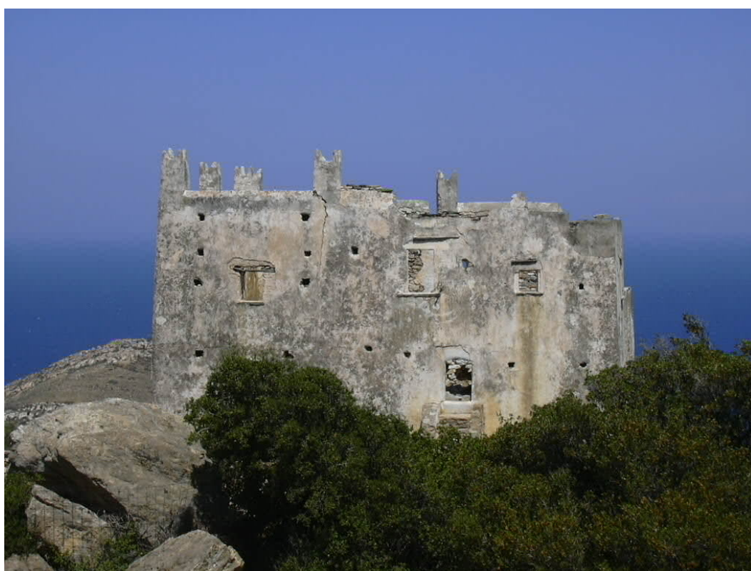
Εικ.44 – Ο Πύργος της Αγιάς με φανερά τα σημάδια της πυρκαγιάς του 1992
