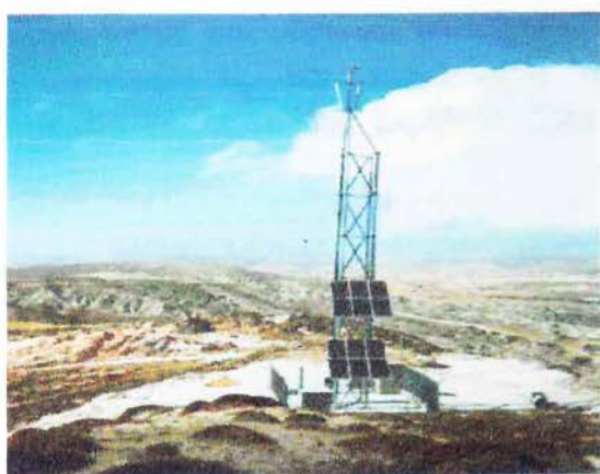
Φ/Β σύστημα για τις ανάγκες ηλεκτροδότησης Α/Δ της Vodafone στη Μήλο
