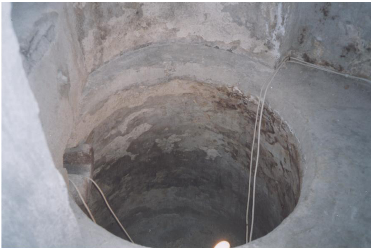
εικ.10 Πάνω βλέπουμε έναν Ληνό καθώς και την οπή του μέσα από την οποία ρέει ο μούστος κατά το πάτημα των σταφυλιών
