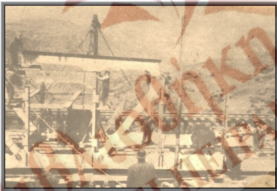
Εικόνα 42: Συναρμολόγηση λυόμενης γέφυρας Roth - Waagner (Everall) άνοιγμα 33m
