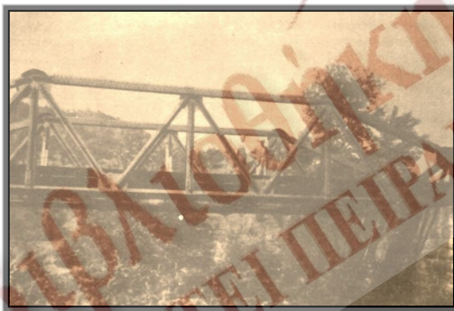
Εικόνα 24: Τύπος παλιάς γέφυρας της γραμμής Θεσσαλονίκη - Αλεξανδρούπολη με άνοιγμα 15.90m (αρχική κατασκευή του Οθωμανικού Σιδηροδρόμου)
