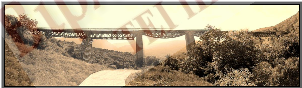
Εικόνα 54: Η σημερινή μορφή της γέφυρας Γοργοποτάμου
