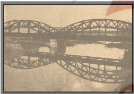
Εικόνα 27: Αρχική σιδηροδρομική γέφυρα Αξιού όπου αποτελείται από δώδεκα αμφιέριστους τόξωτους φορείς θεωρητικού ανοίγματος 28.00m από τα λίθινα βάθρα
