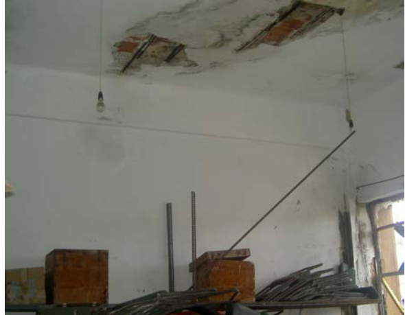
Εικόνα 46,47. Αποκόλληση επιχρισμάτων και σκυροδέματος από την οροφή του α' ορόφου
