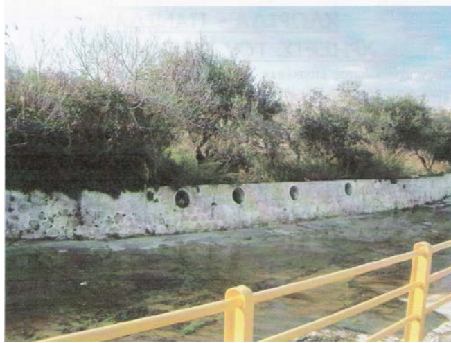
Εικόνα 128. Αγωγοί ομβρίων κατά μήκος του ποταμού.
