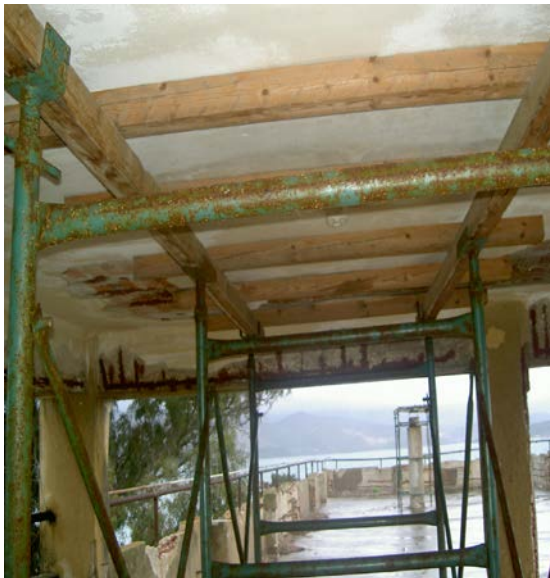
Εικόνα 49. Υποστήριξη καλύπτρου στο δώμα
