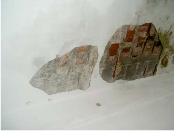
Εικόνα 46,47. Αποκόλληση επιχρισμάτων και σκυροδέματος από την οροφή του α' ορόφου
