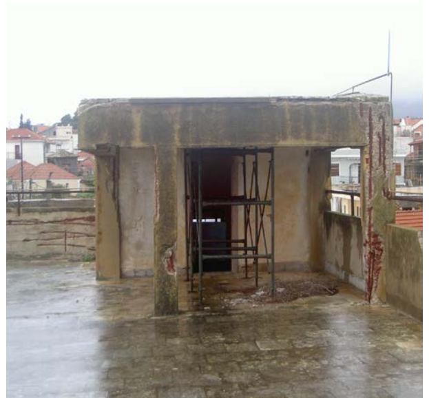
Εικόνα 50. Δώμα Τεχνική ενίσχυσης καλύπτρου.
