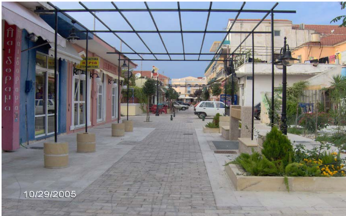
Εικόνα 87. Πεζόδρομος Γρ. Λαμπράκη
