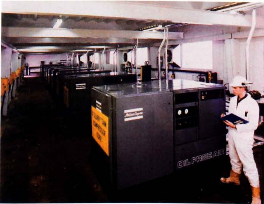
Εικόνα 12: Κεντρικός αεροσταθμός
