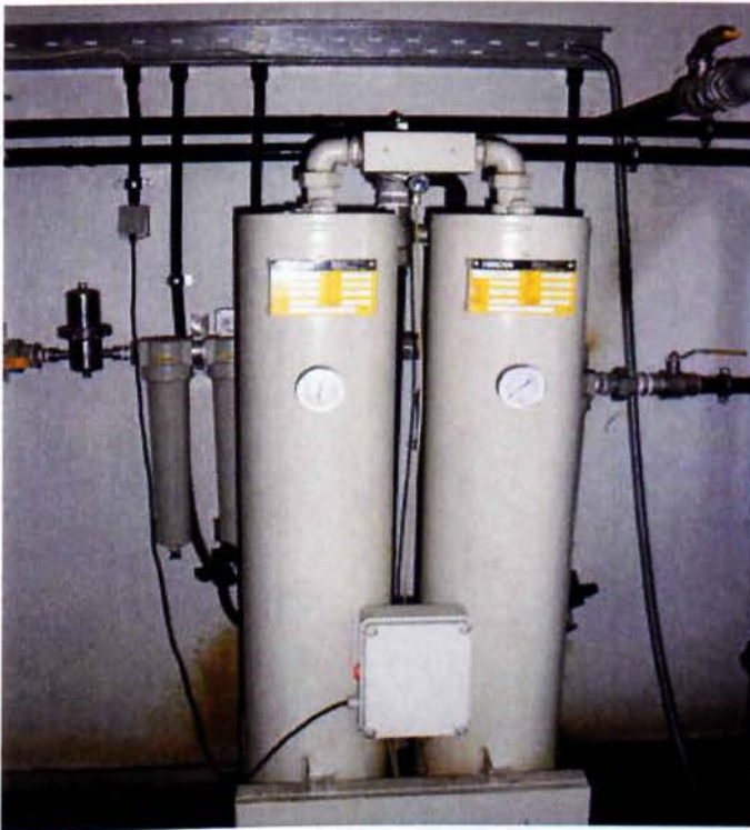
Εικόνα ΠΙΙ 1: Ξηραντής κέντρου παραγωγής πεπιεσμένου αέρα
