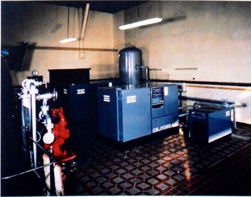
Εικόνα 13: Αποκεντρωμένος αεροσταθμός
