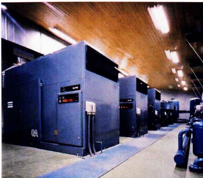
Εικόνα 1: Οργανωμένα συστήματα αεροσυμπιεστών
