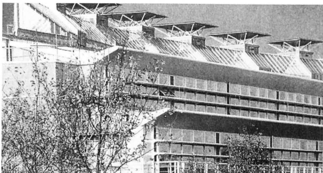
Εικόνα 3 IONICA, Κτίριο Γραφείων στο Cambridge - καμινάδες αερισμού (Αρχιτ: R. H. Partnership, 1994)
