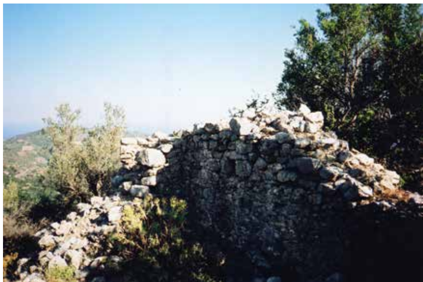
Άλλη άποψη των χαλασμάτων
