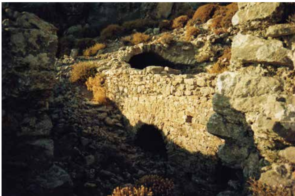
Άλλες σωζόμενες Ενετικές κατασκευές στο λόφο Κέρατο
