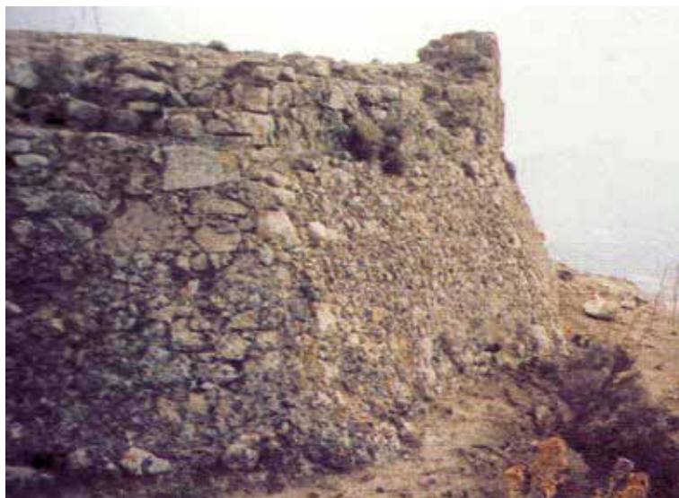
τμήμα τείχους του φρουρίου Νουνο
