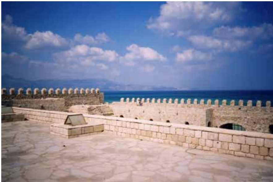
Άλλη άποψη του δώματος του φρουρίου Διακρίνονται τα ανοίγματα που λειτουργούσαν για εξαερισμό και φωτισμό
