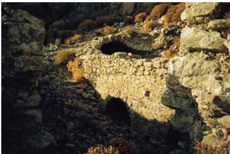
Άλλες σωζόμενες Ενετικές κατασκευές στο λόφο Κέρατο
