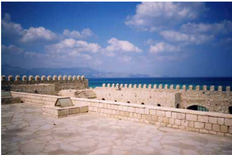
Άλλη άποψη του δώματος του φρουρίου Διακρίνονται τα ανοίγματα που λειτουργούσαν για εξαερισμό και φωτισμό
