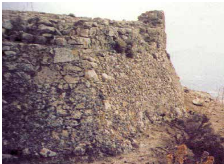
τμήμα τείχους του φρουρίου Νουνο
