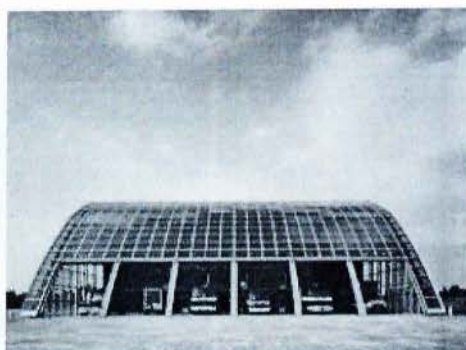
σχήμα 6.6 Ενσωμάτωση φωτοβολταϊκών σε πυροσβεστικό σταθμό
