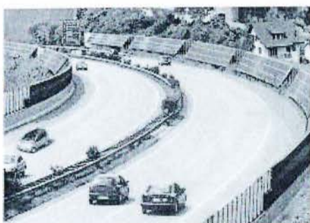
Σχήμα 6.7:Εφαρμογή φωτοβολταϊκών σε ρόλο ηχοφράγματος σε αυτοκινητοδρόμους
