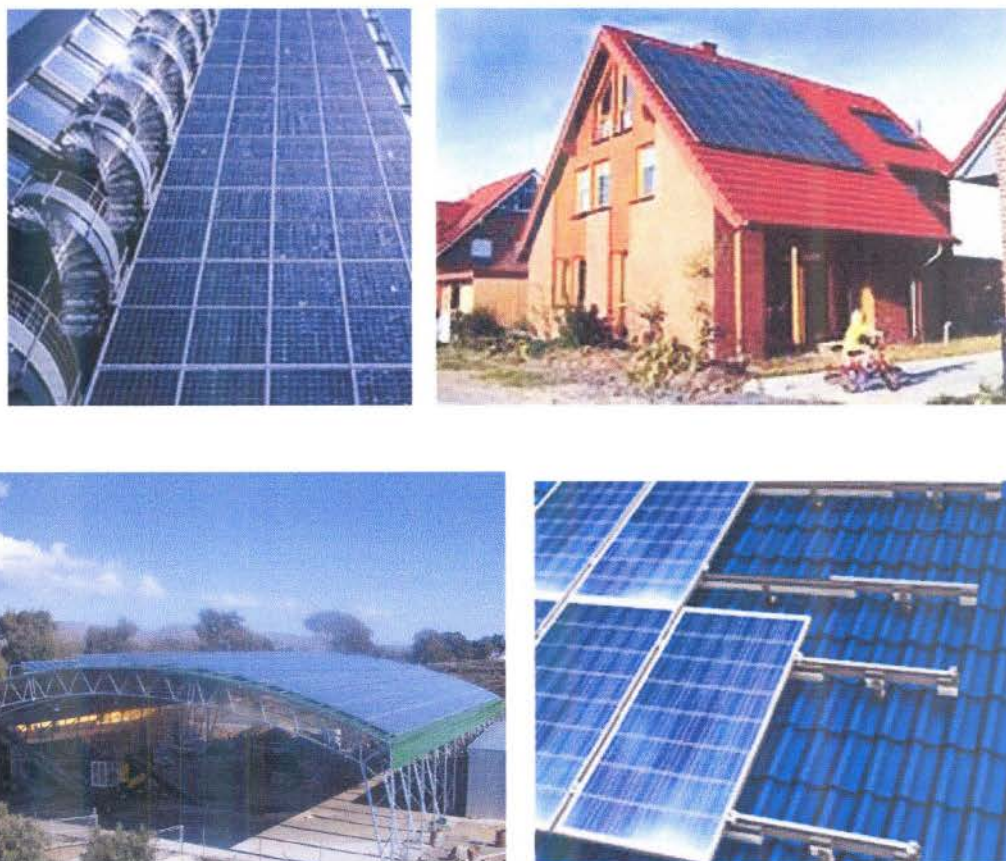
Εικόνα 11 Διάφορες εγκαταστάσεις Φ/Β Πλαισίων
