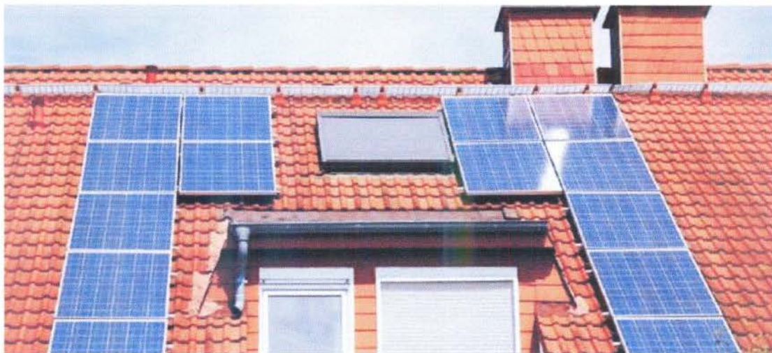
Εικόνα 1. Εγκατάσταση Φ/Β συστήματος σε στέγη
