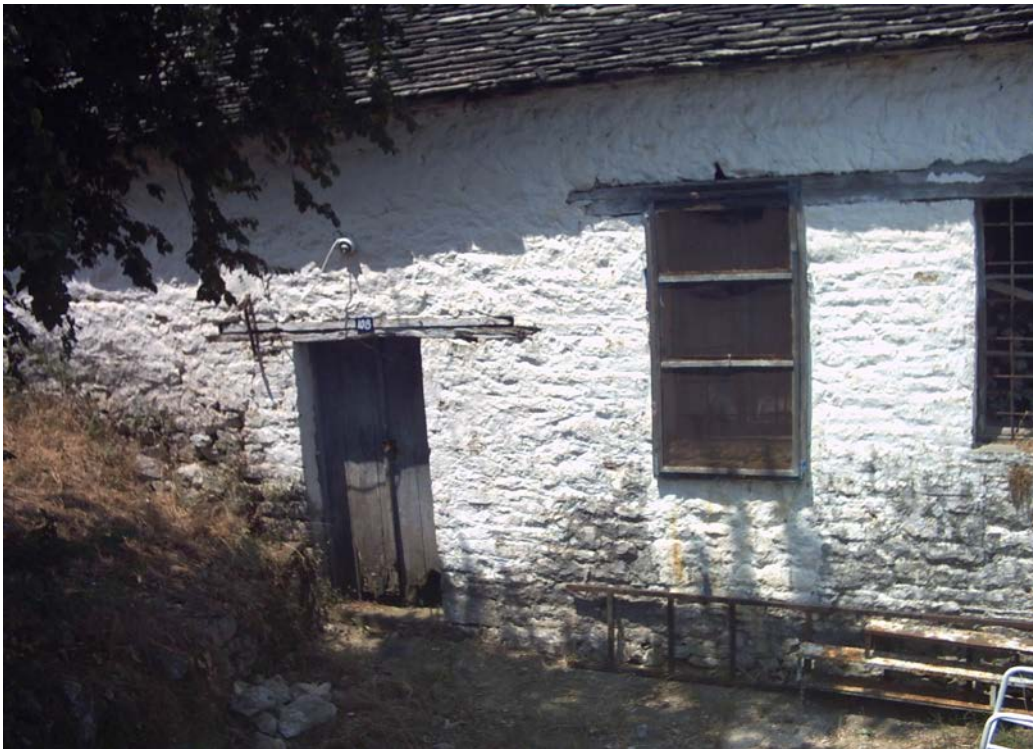
Εικόνα 1: Εξωτερική πόρτα με ξύλινο πρέκι
