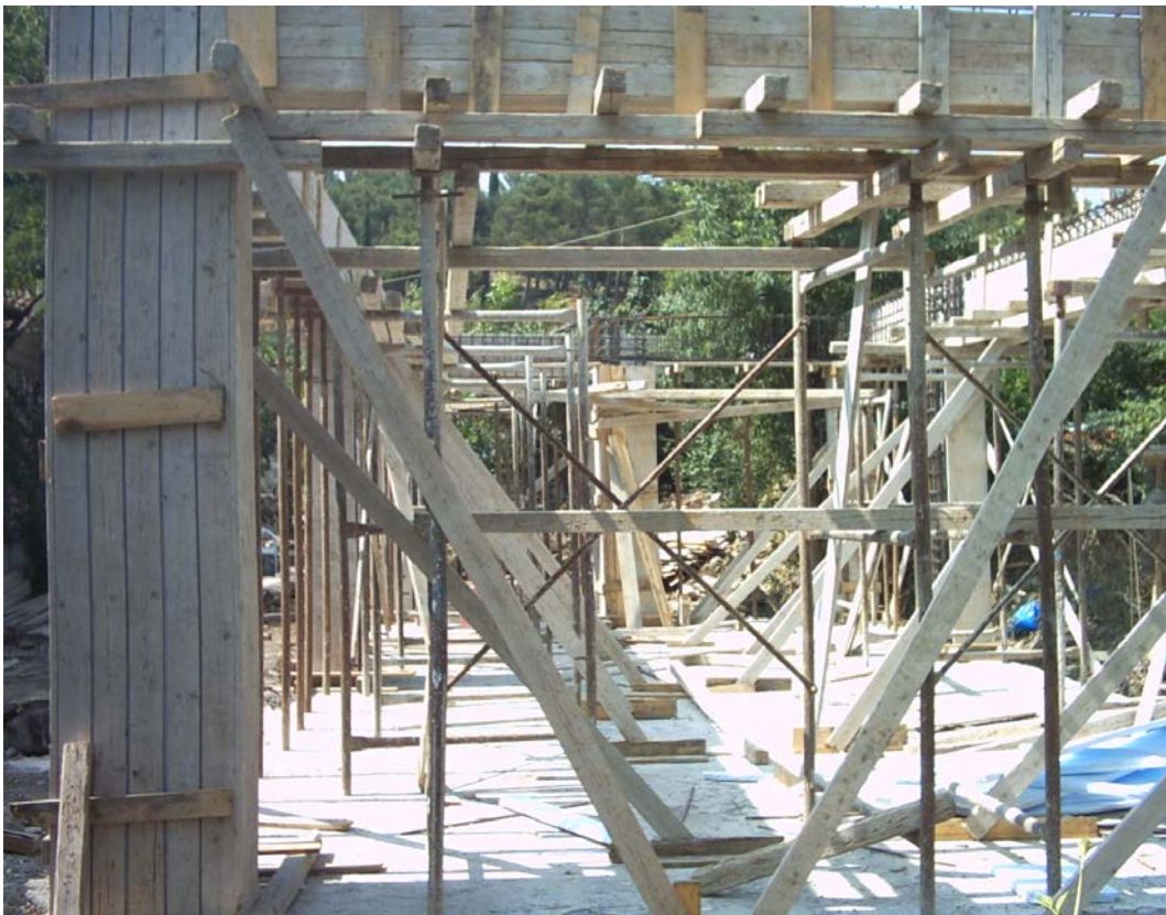
Εικόνα 9 : Κατασκευή καινούργιου οικοδομήματος .
