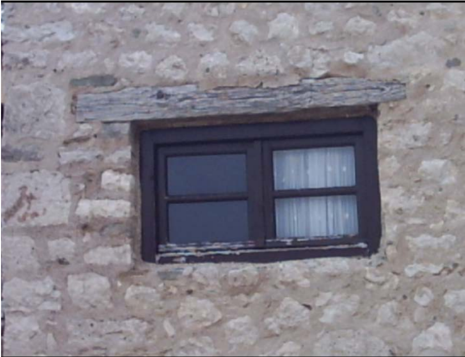
Εικόνα 16 : Παράθυρο με ξύλινο ανώφλι.
