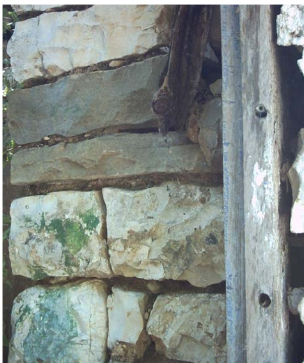
Εικόνα 2: Εξωτερικός τοίχος με κάσωμα
