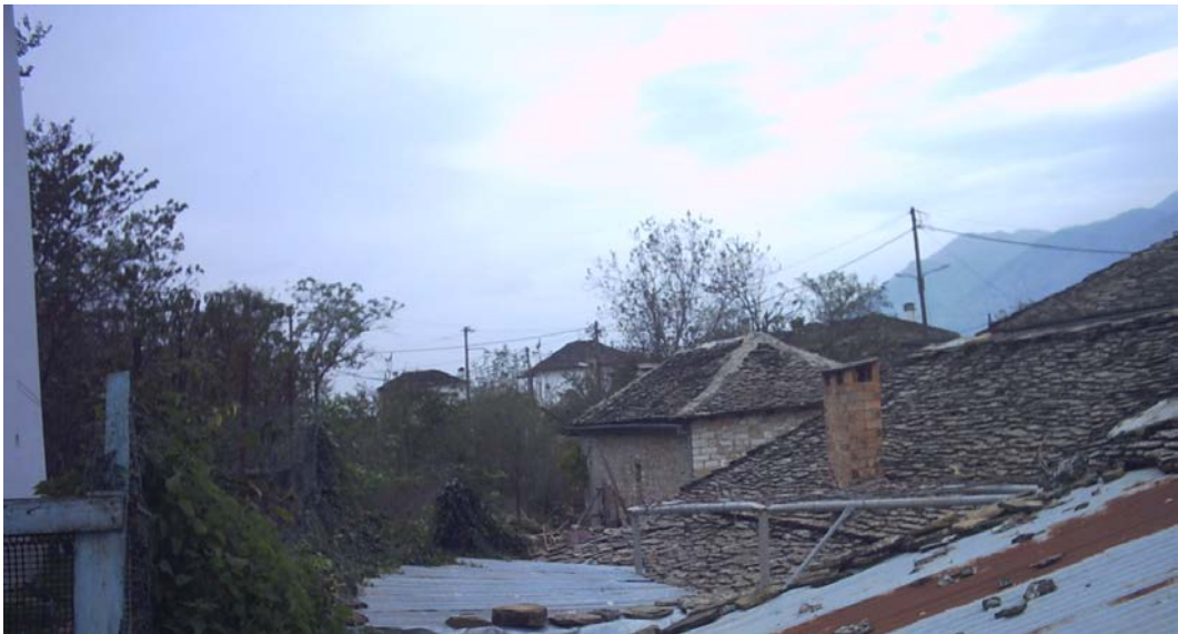
Εικόνα 5 : Στέγες από μαυρόπλακα.
