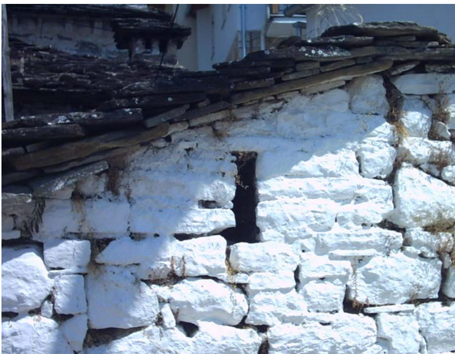
Εικόνα 8 : Μικρό παράθυρο για λόγους ασφαλείας .
