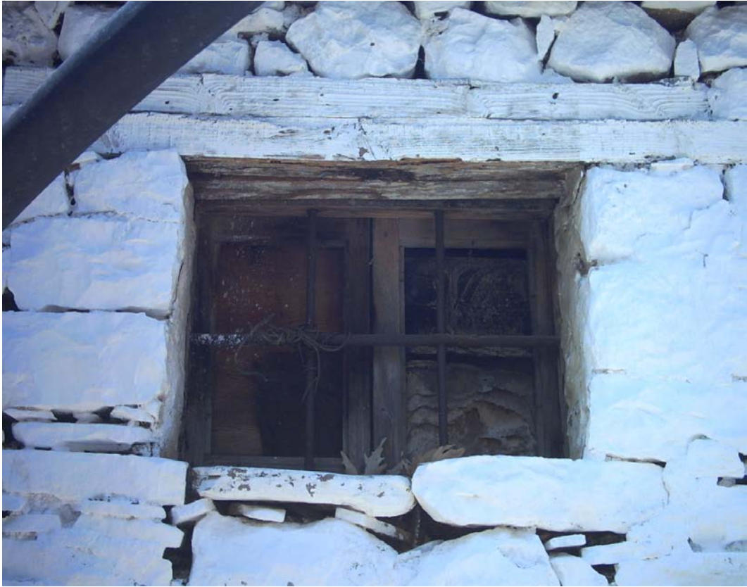
Εικόνα 9: Χαρακτηριστικό παράθυρο χωρίς ποδιά
