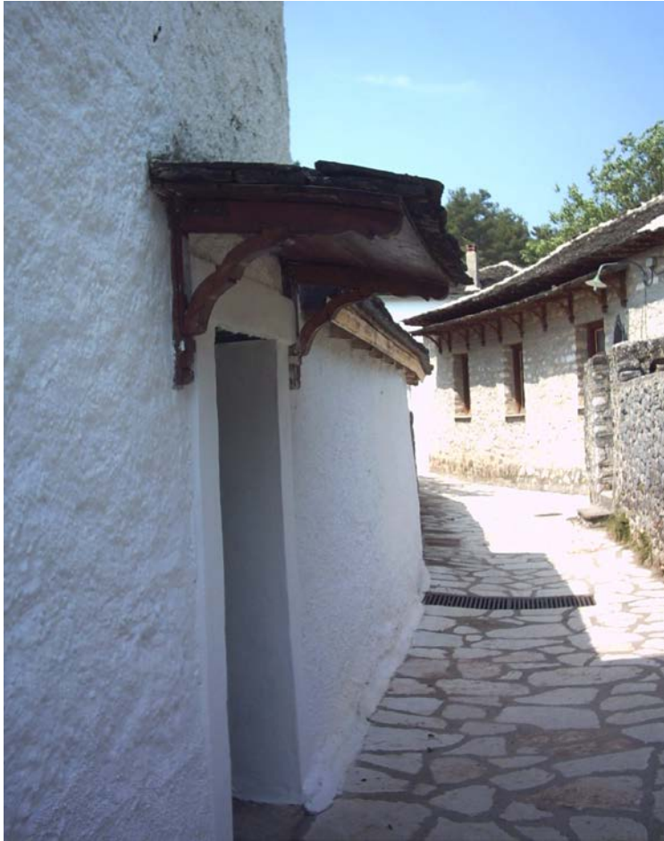
Εικόνα 7 : Σκίαστρο μεμονωμένο από μαυρόπλακα.
