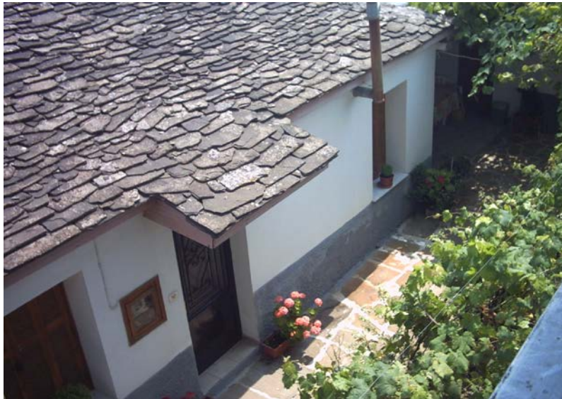
Εικόνα 4 : Σκίαστρο συνέχεια στέγης από μαυρόπλακα.
