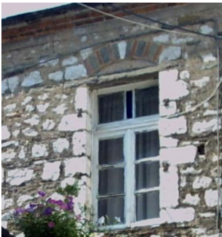
Εικόνα 20 : Παράθυρα μεγαλύτερου μεγέθους, με πέτρινα ανώφλια.
