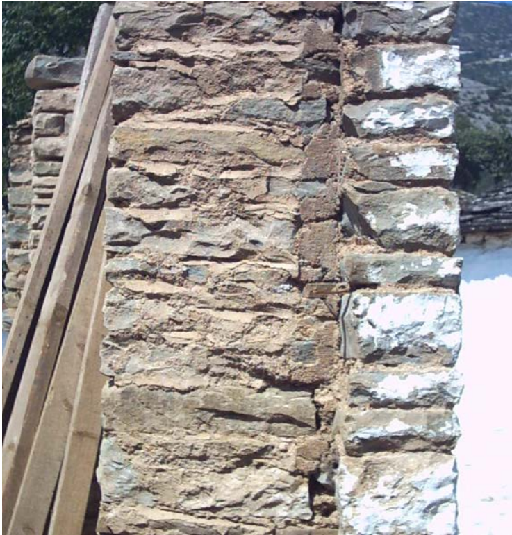
Εικόνα 3 : Τομή εξωτερικού τοίχου.
