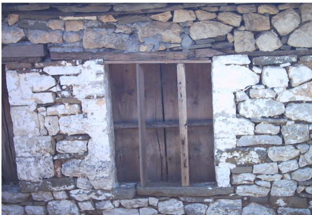
Εικόνα 6 : Παράθυρο ανοιγόμενο εσωτερικά, χωρίς υαλοστάσιο.
