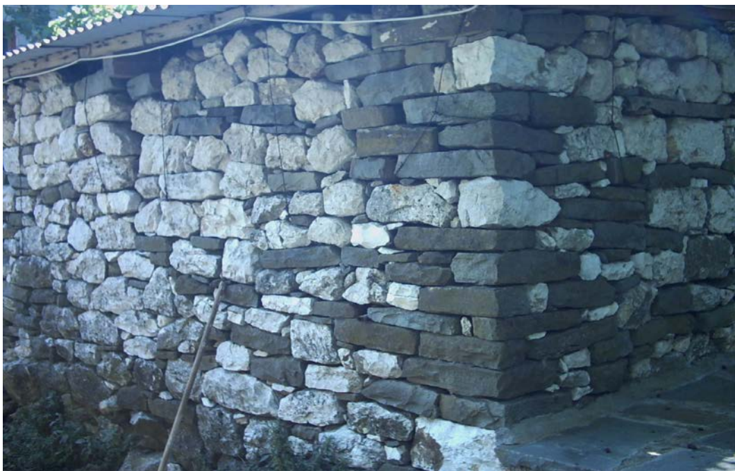
Εικόνα 4 : Εξωτερικός τοίχος με εμφανή λιθοδομή.
