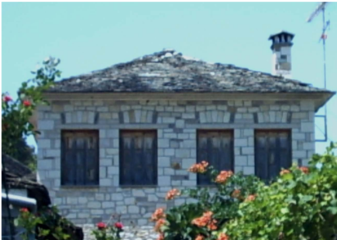
Εικόνα 20 : Παράθυρα μεγαλύτερου μεγέθους, με πέτρινα ανώφλια.
