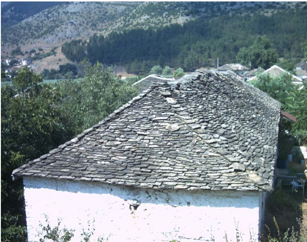
Εικόνα 3 : Όψη στέγης από μαυρόπλακα.
