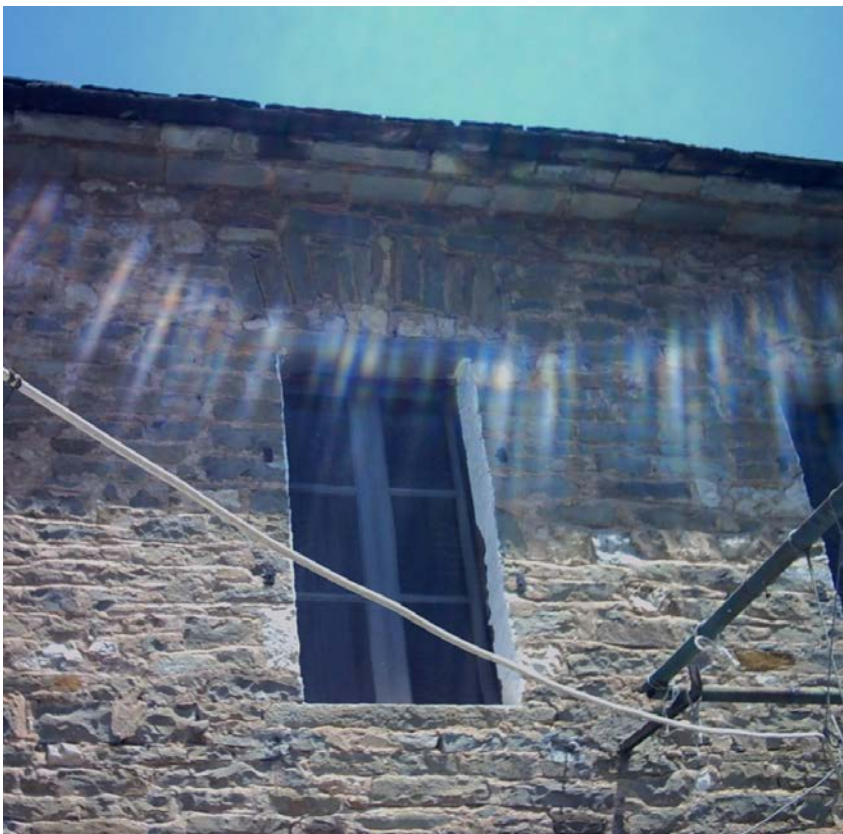
Εικόνα 15: Παράθυρο με πέτρινο ανόφλι.
