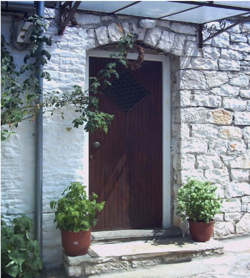
Εικόνα 3 : Πόρτα με πέτρινο πρέκι και τοξωτό ανώφλι.
