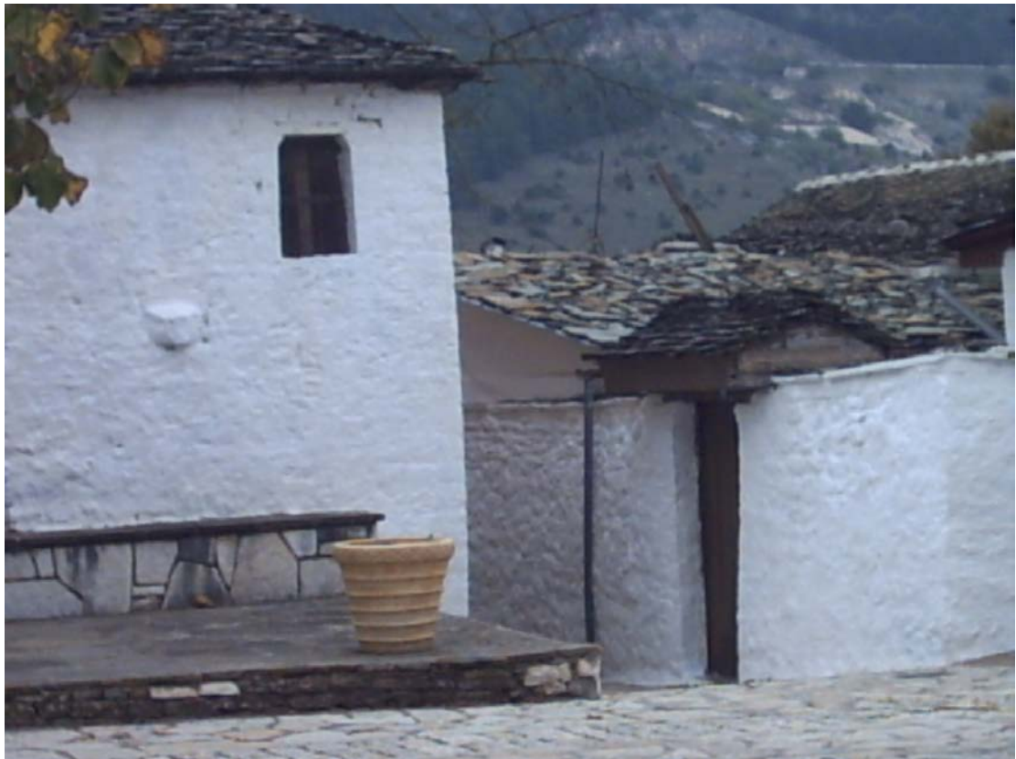
Εικόνα 6 : Εξωτερικός τοίχος και μανδρότοιχος περασμένα με ασβέστη.
