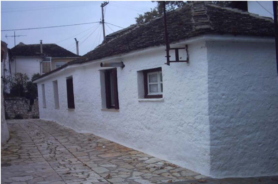
Εικόνα :5 Εξωτερικός τοίχος από ασβέστη και κονίαμα.
