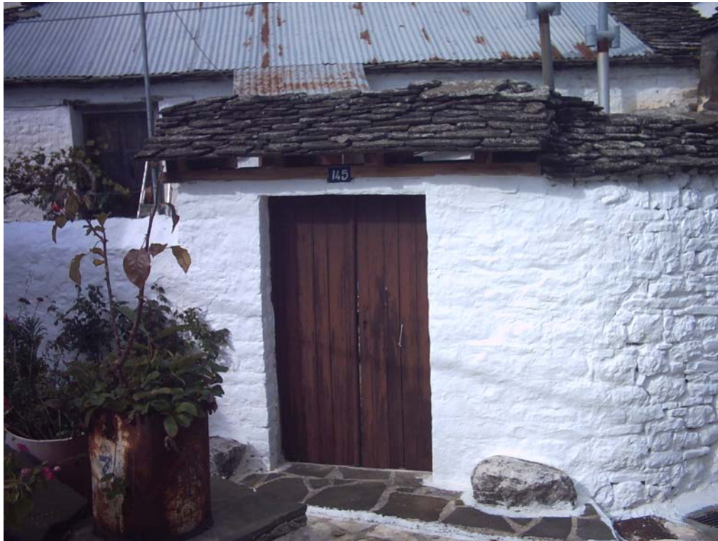
Εικόνα 13 : Ξύλινη αυλόπορτα , με στέγαστρο από μαυρόπλακα.
