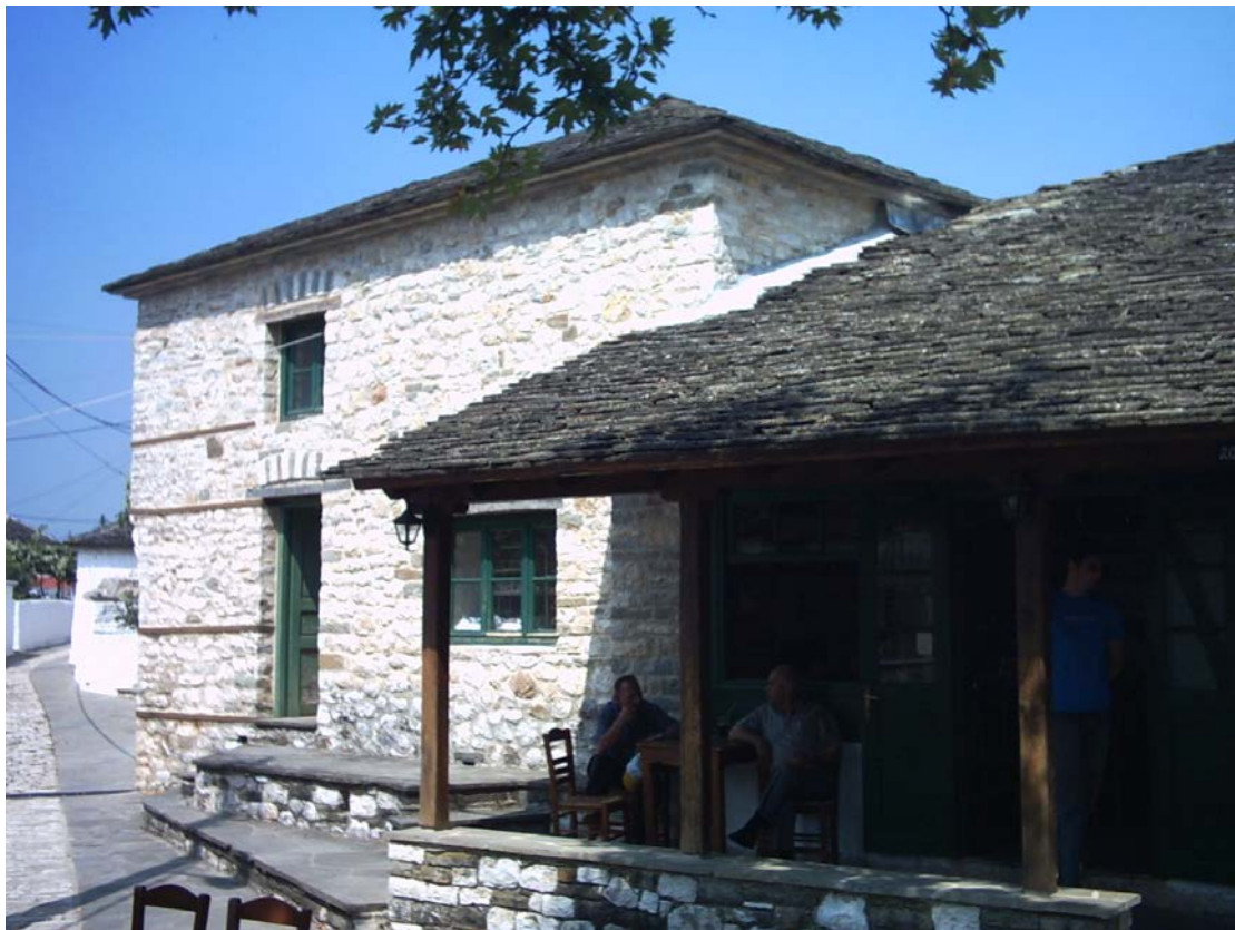
Εικόνα 10 : Ορατό σενάζ (ξυλοδεσιά) τοίχου .
