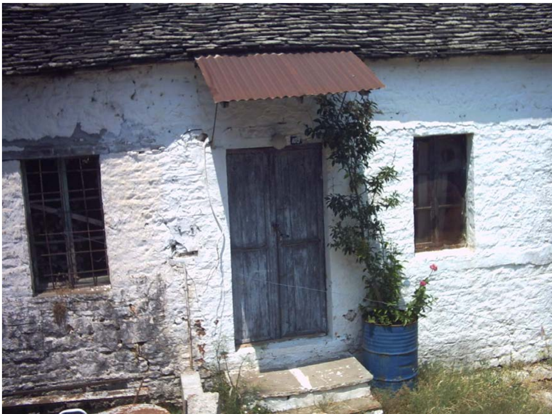
Εικόνα 5 : Πόρτα με σκίαστρο από λαμαρίνα.
