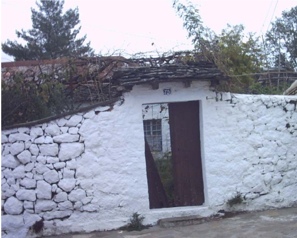
Εικόνα 15 : Αυλόπορτα τοποθετημένη σε πλαίσιο μανδρότοιχου.
