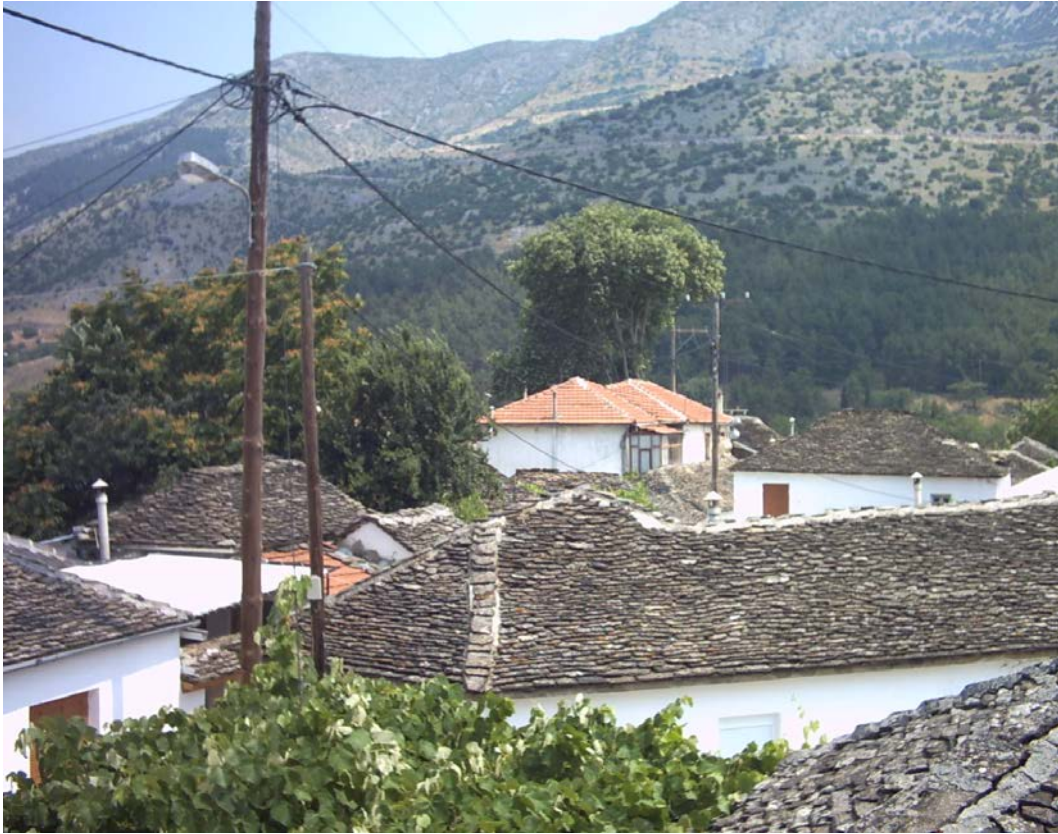
Εικόνα 6 : Στέγες από μαυρόπλακα και κεραμίδια.
