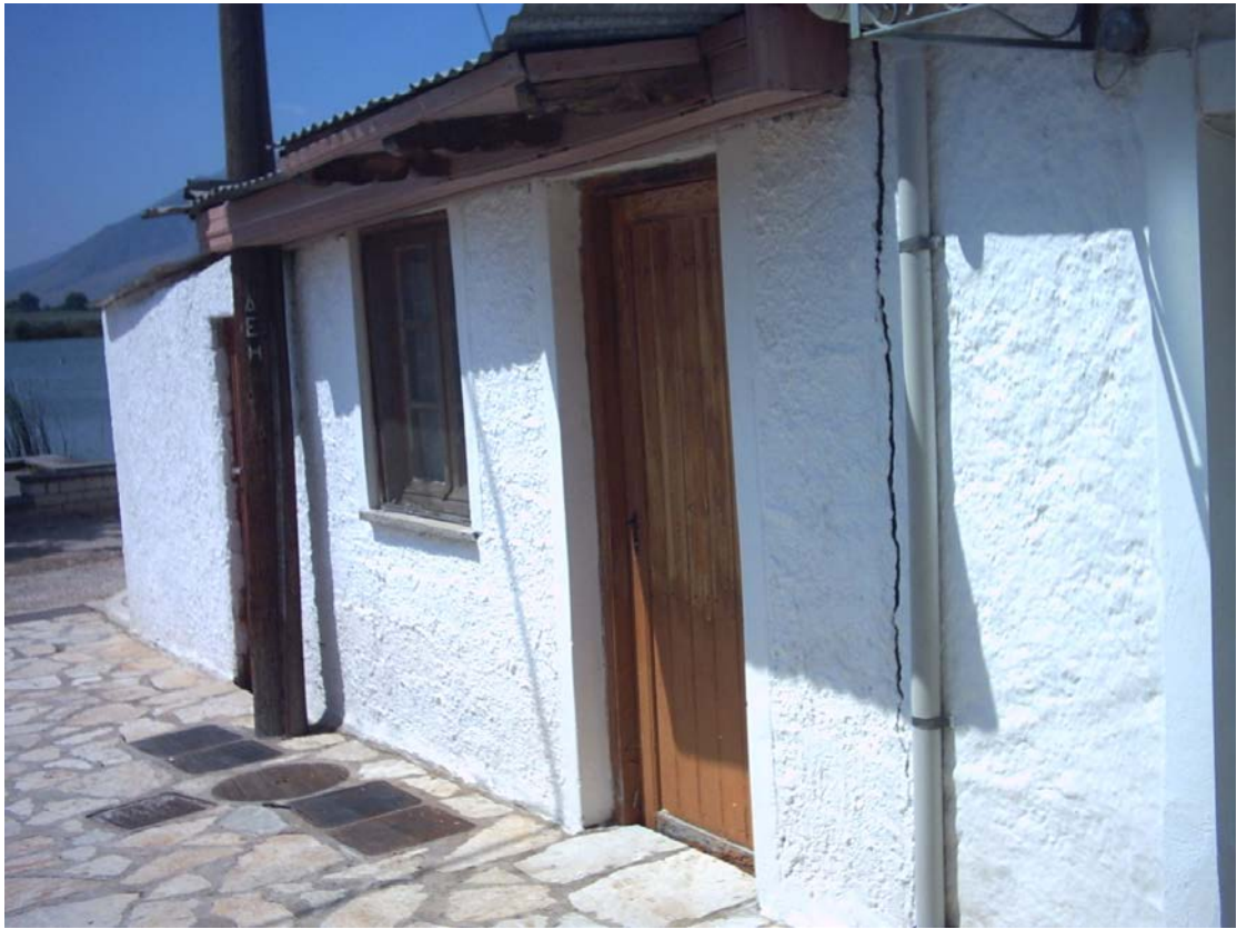
Εικόνα 6 : Πόρτα με σκίαστρο από λαμαρίνα (μεμονωμένο).
