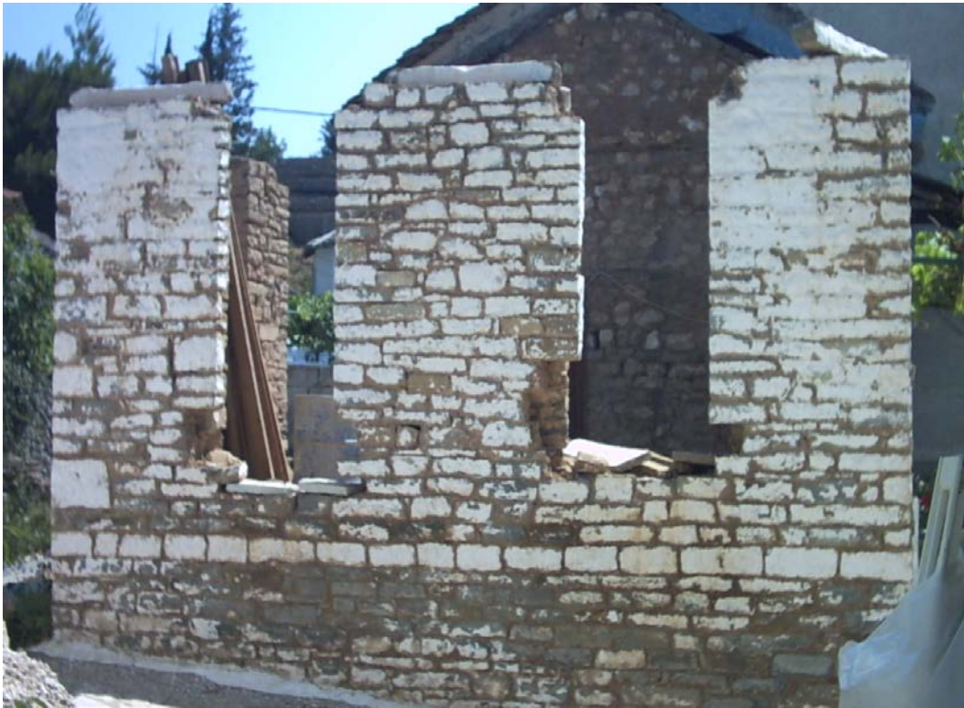
Εικόνα 8 : Ανακατασκευή παλιού οικοδομήματος .
