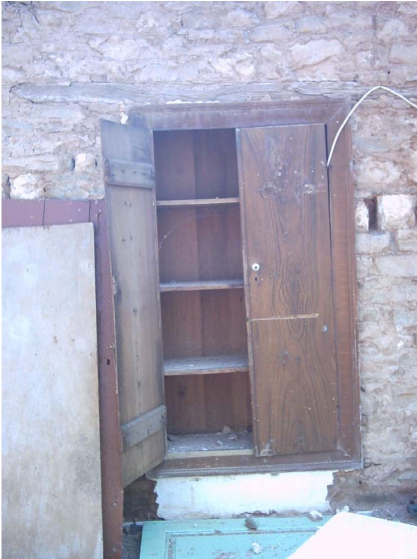
Εικόνα 5 : Εντοιχισμένο ντουλάπι
